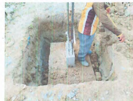
ARMAÇÃO E CONCRETAGEM DA SAPATA
