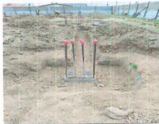
ESCAVAÇÃO DE VIGA BALDRAME
