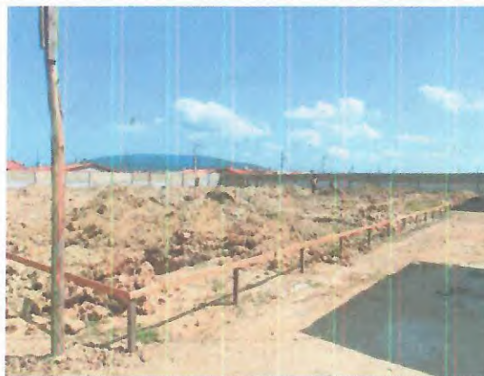
LOCAÇÃO DE OBRA
