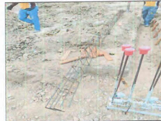
ARMAÇÃO VIGA BALDRAME
