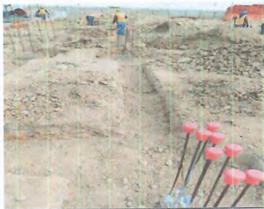
ESCAVAÇÃO DE VIGA BALDRAME
