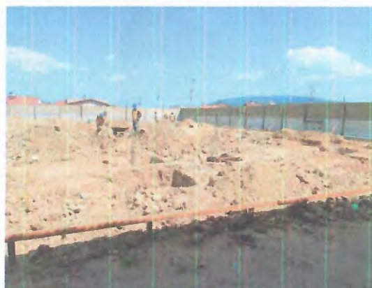
ESCAVAÇÃO PARA BLOCO DE COROAMENTO OU SAPATA
