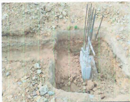
ARMAÇÃO E CONCRETAGEM DA SAPATA
