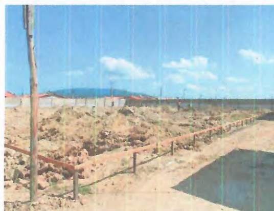
REATERRO DE VALA
