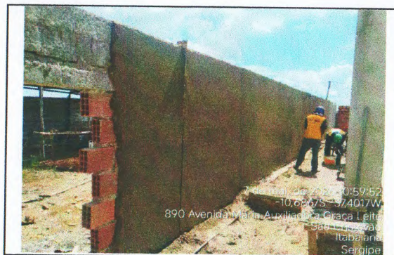
MURO EM ALVENARIA DE BLOCO CERÂMICO
