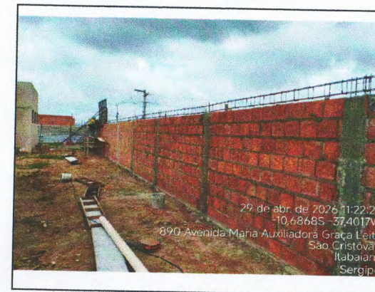
MURO EM ALVENARIA DE BLOCO CERÂMICO
