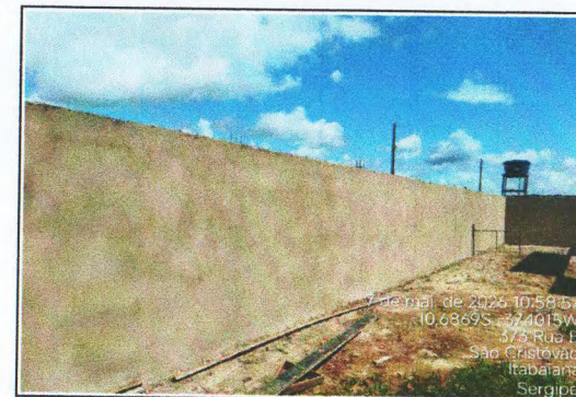
MURO EM ALVENARIA DE BLOCO CERÂMICO
