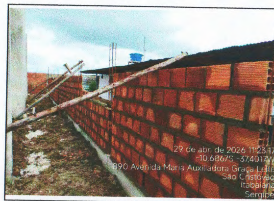
MURO EM ALVENARIA DE BLOCO CERÂMICO
