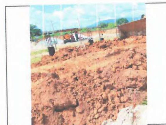
EXECUÇÃO DO ATERRO COM MATERIAL DE SUB-BASE
