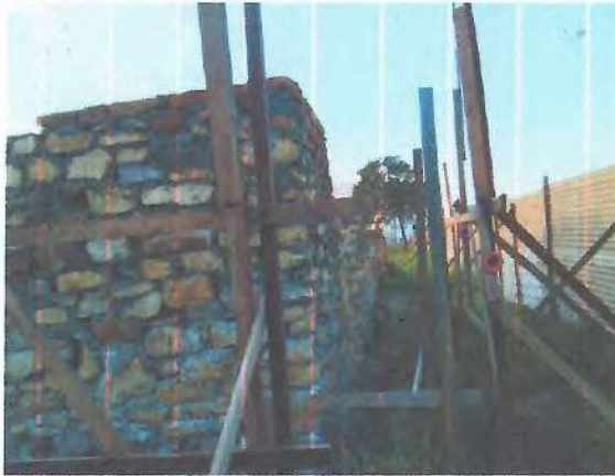
ALVENARIA DE PEDRA ARGAMASSADA; FECHAMENTO COM TAPUME EM TELHA DE AÇO
