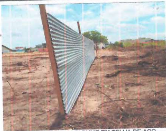
FECHAMENTO COM TAPUME EM TELHA DE AÇO
