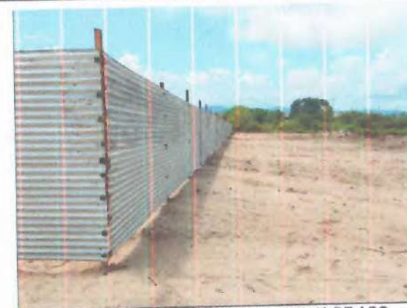
FECHAMENTO COM TAPUME EM TELHA DE AÇO
