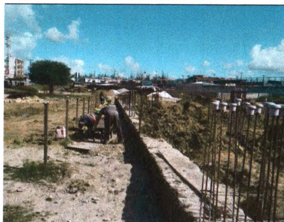
ALVENARIA DE PEDRA, AÇO DOS PILARES E SAPATAS
