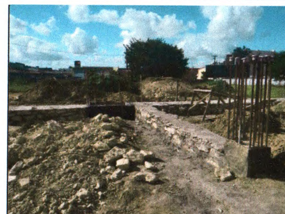
ALVENARIA DE PEDRA, AÇO DOS PILARES E SAPATAS
