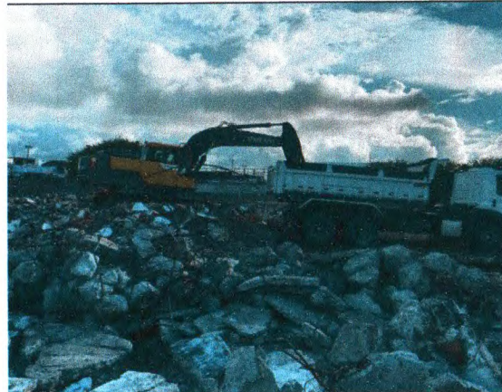
DEMOLIÇÃO, CARGA DOS ENTULHOS E TRANSPORTE
