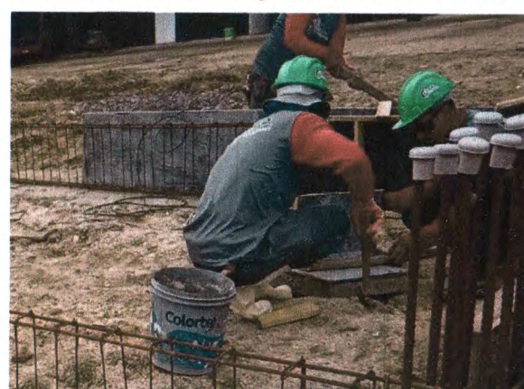
CORTE E DOBRA DE AÇO DAS VIGAS BALDRAME
