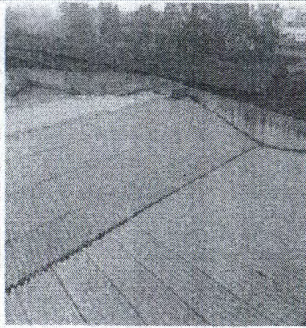
RUFO DE CONCRETO
