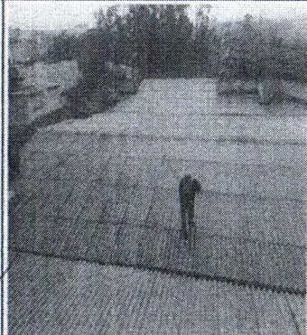
RUFO DE CONCRETO
