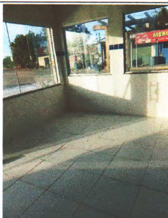
REJUNTAMENTO DE PISO E PAREDE
