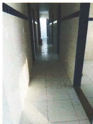
REJUNTAMENTO DE PISO E PAREDE
