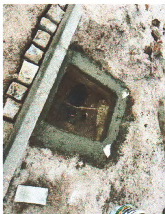
EXECUÇÃO DE TAMAPA DE CONCRETO
