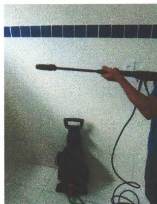
lavagem de parede
