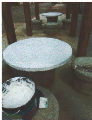
EXECUÇÃO DE MESA E CADEIRA COM MANILHAS DE CONCRETO
