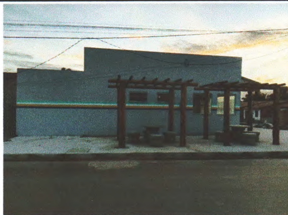
Instalação de portas
