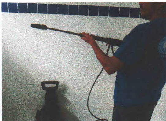
lavagem de parede
