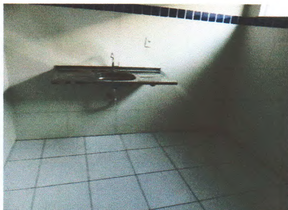
REJUNTAMENTO DE PISO E PAREDE
