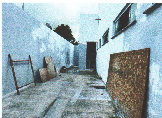
EMASSAMENTO DE PAREDE
