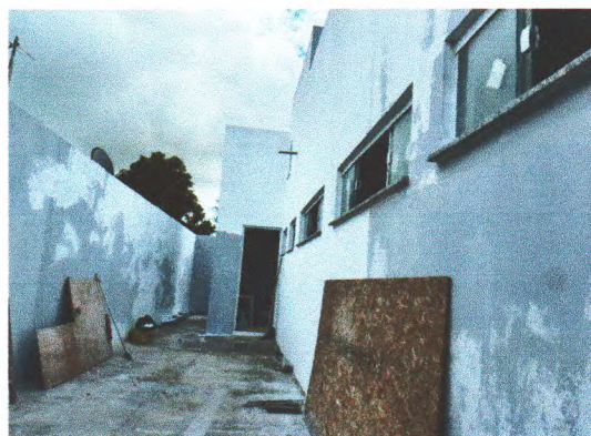
EMASSAMENTO DE PAREDE
