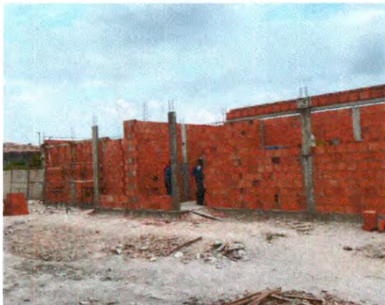
ALVENARIA, PILARES, CINTAS E VERGAS
