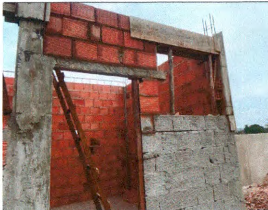
ALVENARIA, PILARES, CINTAS E VERGAS
