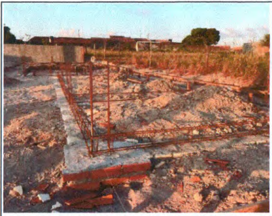
BLOCOS/SAPATAS E VIGAS BALDRAME
