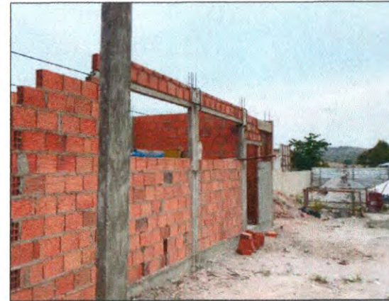
ALVENARIA, PILARES, CINTAS E VERGAS
