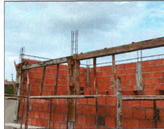
ALVENARIA, PILARES, CINTAS E VERGAS
