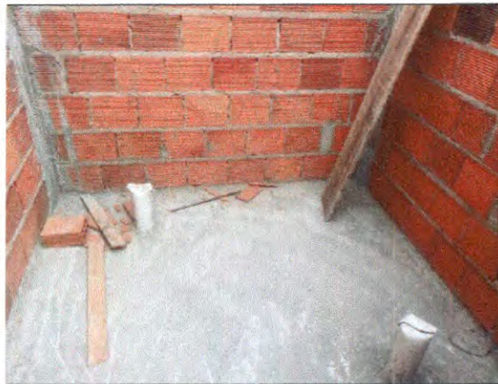
ALVENARIA, INSTALAÇÕES SANITÁRIAS E CONTRAPISO
