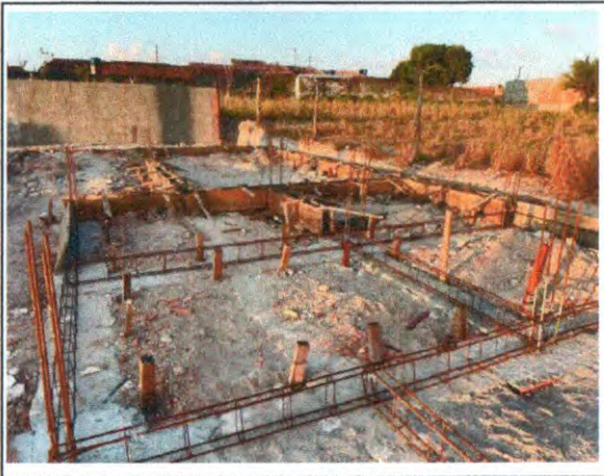
BLOCOS/SAPATAS E VIGAS BALDRAME
