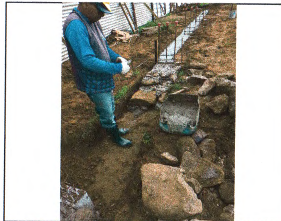
ESCAVAÇÃO; CONCRETO ARMADO SAPATAS E ARRANQUES DOS PILARES; ALVENARIA DE PEDRA
