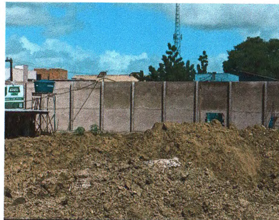
MURO EM ALVENARIA DE BLOCO CERÂMICO REBOCADO
