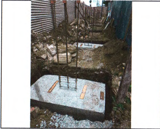
ESCAVAÇÃO; CONCRETO ARMADO SAPATAS E ARRANQUES DOS PILARES; TAPUME METÁLICO
