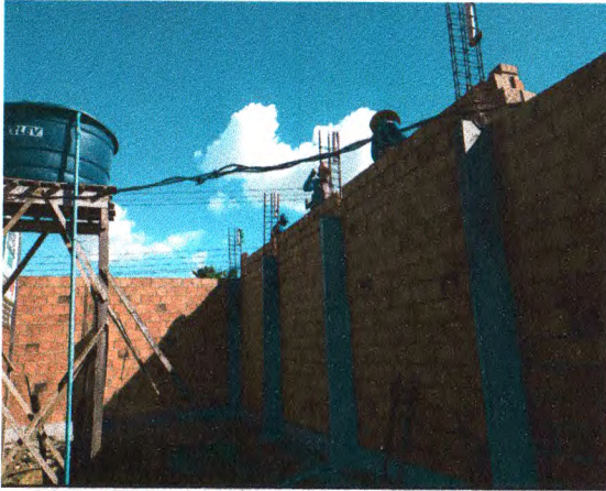
CONCRETO ARMADO PILARES E CINTA INFERIOR; ALVENARIA DE PEDRA E BLOCO CERÂMICO
