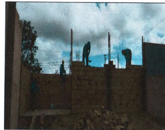
EXECUÇÃO DO ABRIGO DOS RESERVATÓRIOS PARA IRRIGAÇÃO
