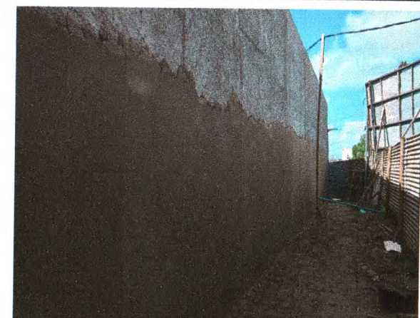
MURO EM ALVENARIA DE BLOCO CERÂMICO; CHAPISCO E REBOCO
