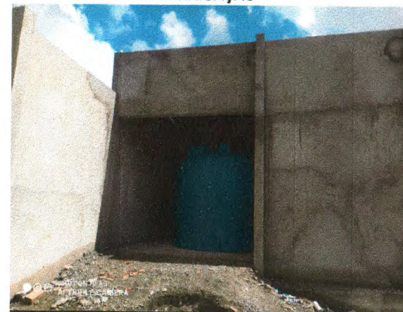
EXECUÇÃO DO ABRIGO DOS RESERVATÓRIOS PARA IRRIGAÇÃO; CAIXA D'ÁGUA 20.000L
