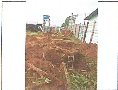
ESCAVAÇÃO MANUAL DE VALA, BARRACÃO PARA OBRA, TAPUME METÁLICO
