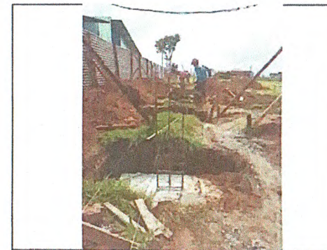
ESCAVAÇÃO, CONCRETO ARMADO SAPATAS E ARRANQUES DOS PILARES, REATERRO, TAPUME METÁLICO
