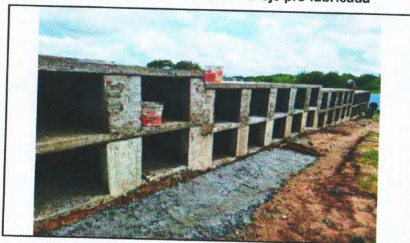
Alvenaria de bloco cerâmico e laje pré-fabricada
