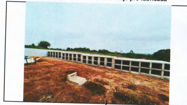
Alvenaria de bloco cerâmico e laje pré-fabricada
