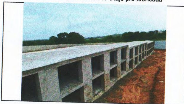
Alvenaria de bloco cerâmico e laje pré-fabricada
