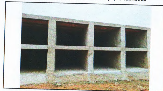
Alvenaria de bloco cerâmico e laje pré-fabricada
