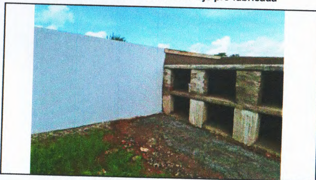
Alvenaria de bloco cerâmico e laje pré-fabricada
