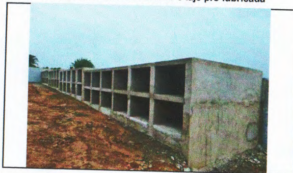
Alvenaria de bloco cerâmico e laje pré-fabricada
