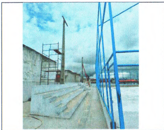
EXECUÇÃO DE ARQUIBANCADA.
