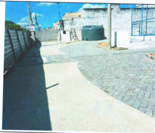
PISO EM CONCRETO DESEMPOLADO E ASSENTAMENTO DE MEIO-FIO.
