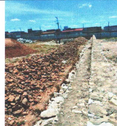
ESCAVAÇÃO E ALVENARIA DE PEDRA CONTENÇÃO QUADRA.
