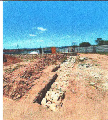
ESCAVAÇÃO E ALVENARIA DE PEDRA CONTENÇÃO QUADRA.
