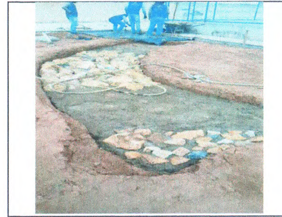
ESCAVAÇÃO E ALVENARIA DE PEDRA ARQUIBANCADA.
