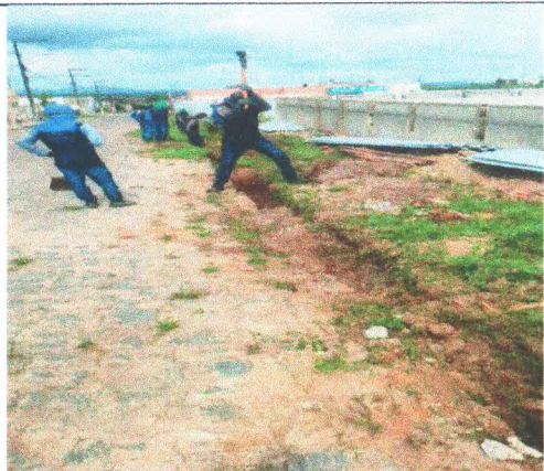
REMOÇÃO DE MEIO-FIO.
