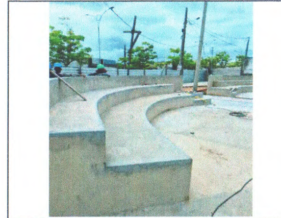
EXECUÇÃO DE ARQUIBANCADA.
