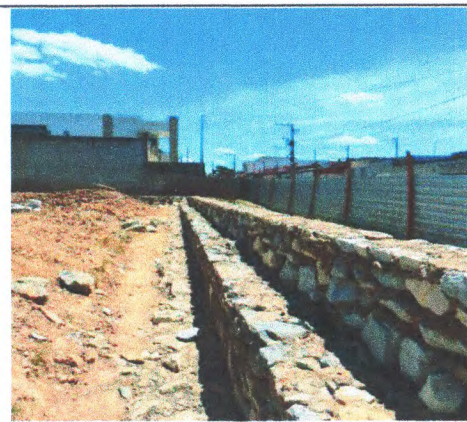
ESCAVAÇÃO E ALVENARIA DE PEDRA CONTENÇÃO QUADRA.
