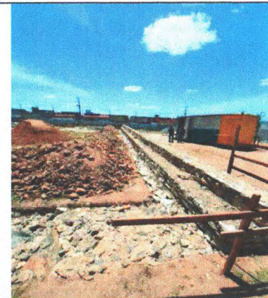
ESCAVAÇÃO E ALVENARIA DE PEDRA CONTENÇÃO QUADRA.
