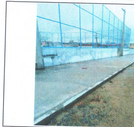
PISO EM CONCRETO DESEMPOLADO E ASSENTAMENTO DE MEIO-FIO.
