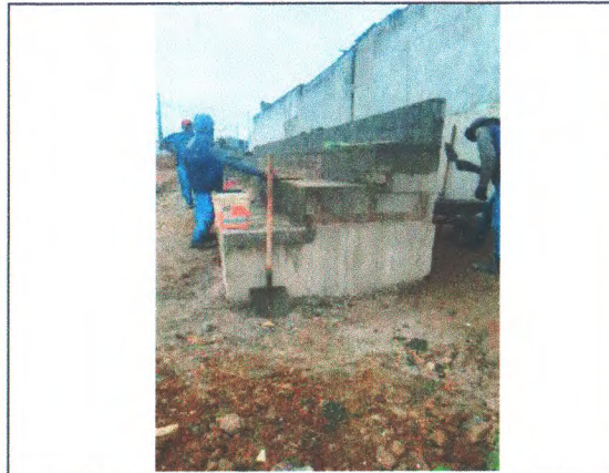
ALVENARIA DE BLOCO E ENCHIMENTO COM CONCRETO EM ARQUIBANCADA.
