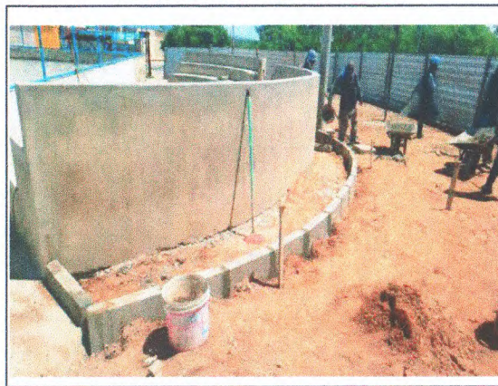
ASSENTAMENTO DE MEIO-FIO.
