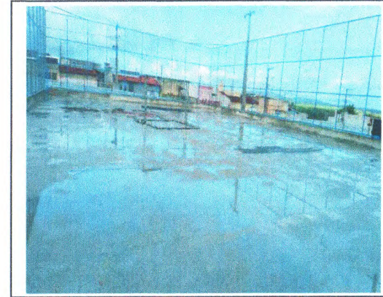
EXECUÇÃO DE PISO EM QUADRA; ALAMBRADO.
