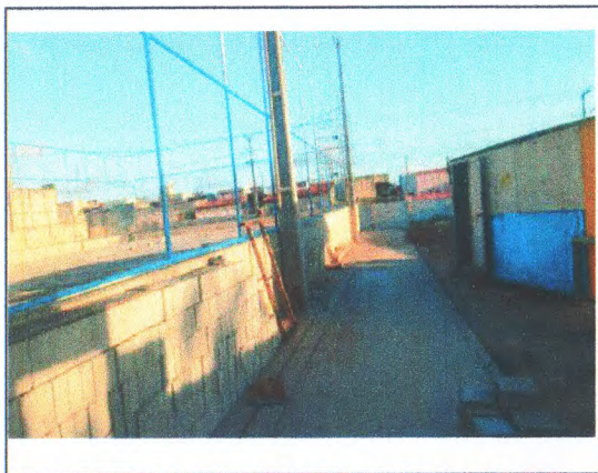
PINTURA METÁLICA EM ALAMBRADO, GALVIT E ESMALTE.
