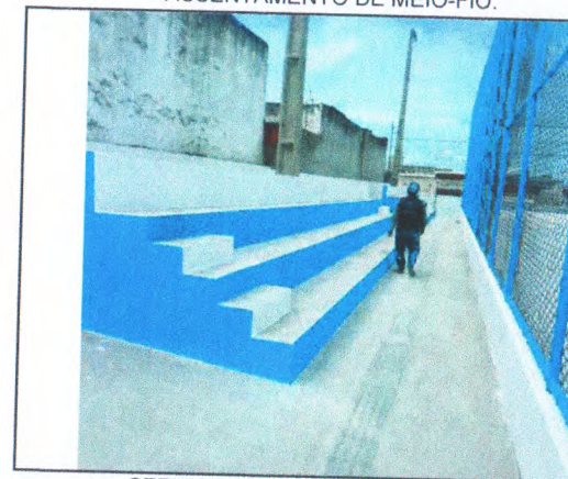
SERVIÇOS DE PINTURA EM GERAL.
