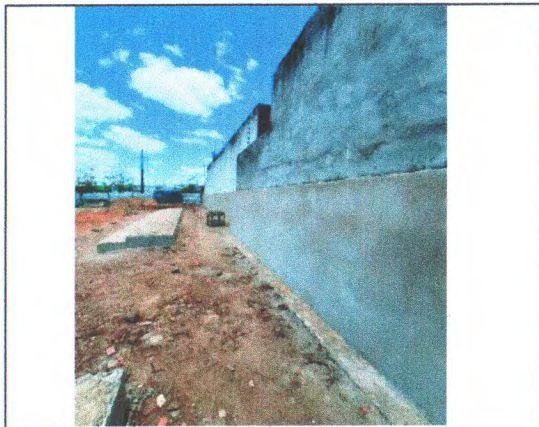
EXECUÇÃO DE MURO.
