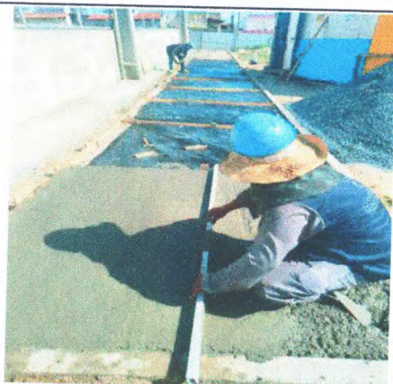
PISO EM CONCRETO DESEMPOLADO E ASSENTAMENTO DE MEIO-FIO.
