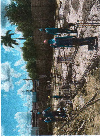
ATERRO COMPACTADO; LONA PLÁSTICA PRETA; CONCRETO MAGRO
