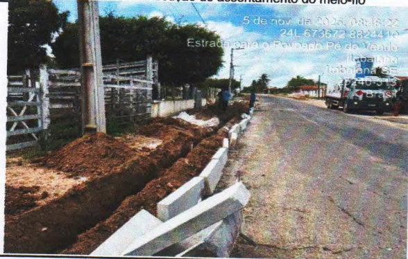
FOTO 11-Execução de assentamento do meio-fio
