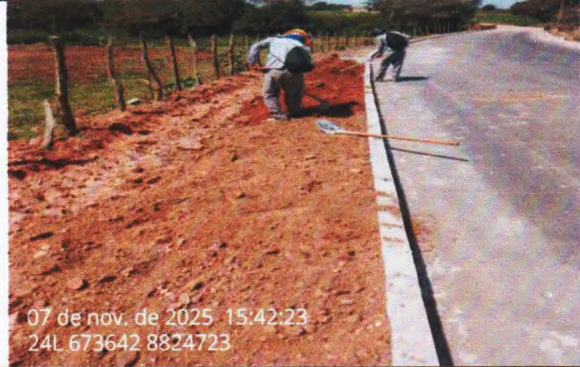
FOTO 14-Execução do aterro e compactação para o escoramento do meio-fio
