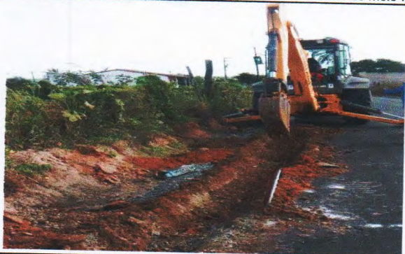
FOTO 11-Execução de assentamento do meio-fio
