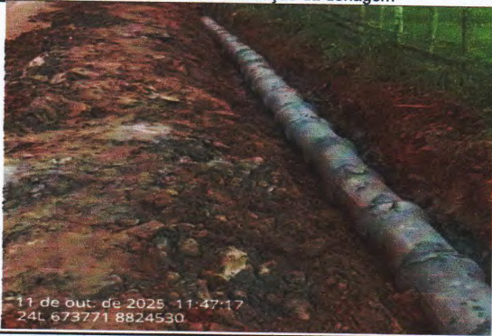
FOTO 03-Execução da denagem
