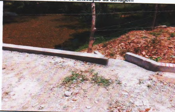
FOTO 10-Execução do aterro para escoramento do meio-fio
