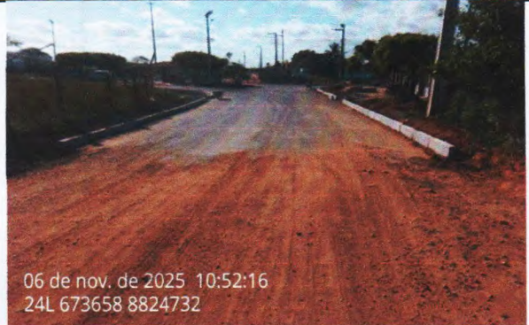
FOTO 15-Execução do aterro e compactação para o escoramento do meio-fio
