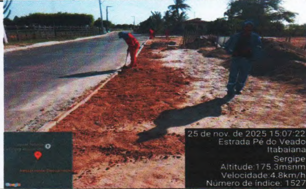
FOTO 15-Execução do aterro e compactação para o escoramento do meio-fio
