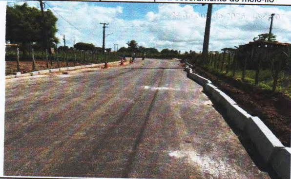
FOTO 12-Execução do aterro e compactação para escoramento do meio-fio
