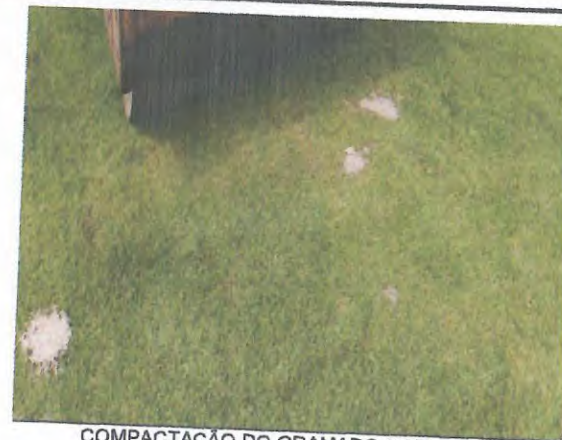
COMPACTAÇÃO DO GRAMADO COM ROLO COMPACTADOR
