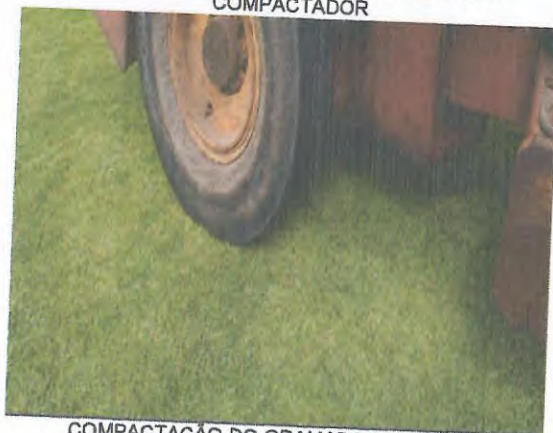
COMPACTAÇÃO DO GRAMADO COM ROLO COMPACTADOR
