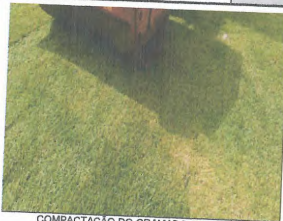
COMPACTAÇÃO DO GRAMADO COM ROLO COMPACTADOR
