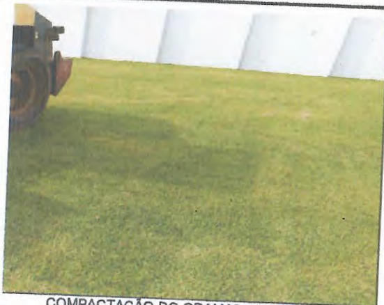
COMPACTAÇÃO DO GRAMADO COM ROLO COMPACTADOR
