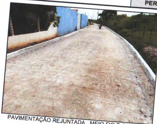
PAVIMENTAÇÃO REJUNTADA, MEIO FIO E CAIAÇÃO
