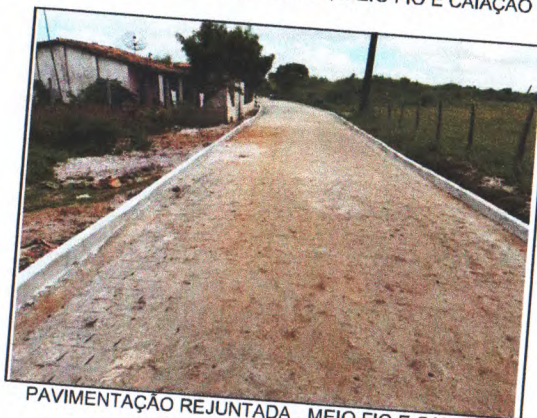
PAVIMENTAÇÃO REJUNTADA, MEIO FIO E CAIAÇÃO
