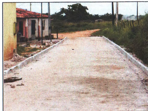
PAVIMENTAÇÃO REJUNTADA, MEIO FIO E CAIAÇÃO
