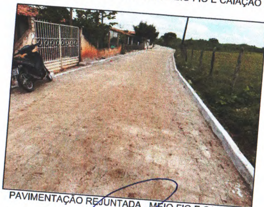
PAVIMENTAÇÃO REJUNTADA, MEIO FIO E CAIAÇÃO
