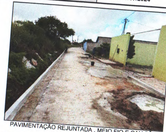
PAVIMENTAÇÃO REJUNTADA, MEIO FIO E CAIAÇÃO
