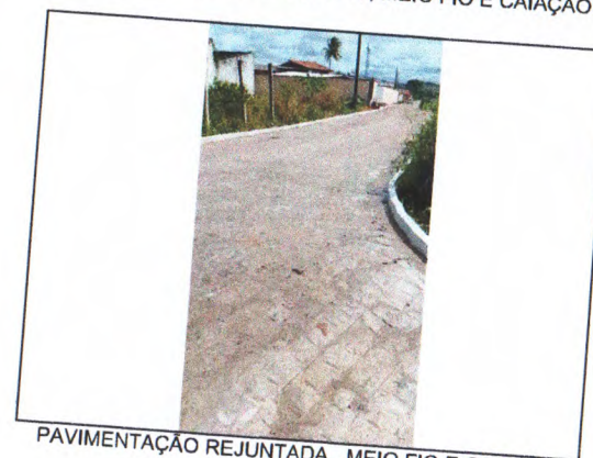
PAVIMENTAÇÃO REJUNTADA, MEIO FIO E CAIAÇÃO
