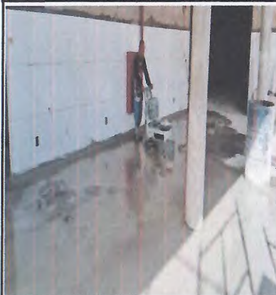
Polimento de piso de alta resistência
