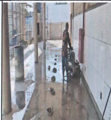
Polimento de piso de alta resistência
