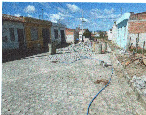
PAVIMENTAÇÃO NA RUA ANA SOUZA DE JESUS
