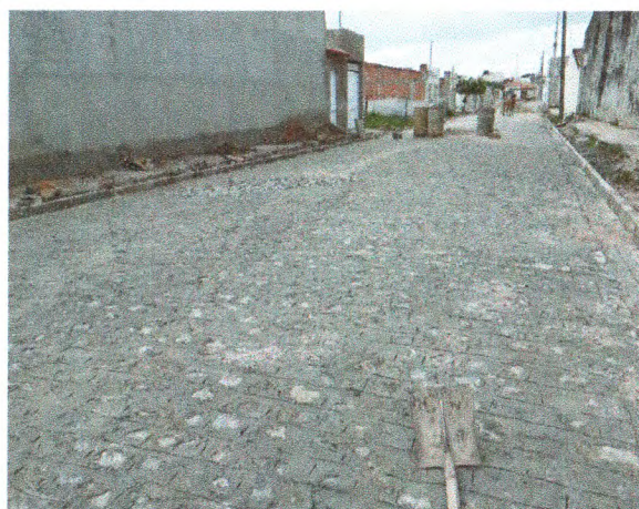
PAVIMENTAÇÃO NA RUA ANA SOUZA DE JESUS
