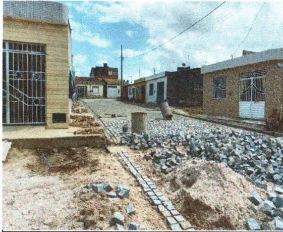
PAVIMENTAÇÃO NA RUA ANA SOUZA DE JESUS
