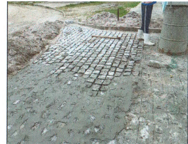
PAVIMENTAÇÃO NA RUA ANA SOUZA DE JESUS
