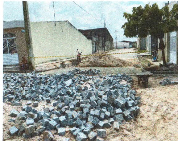
PAVIMENTAÇÃO NA RUA MAURINO JOSÉ DA SILVA
