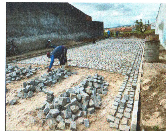
PAVIMENTAÇÃO NA RUA MAURINO JOSÉ DA SILVA
