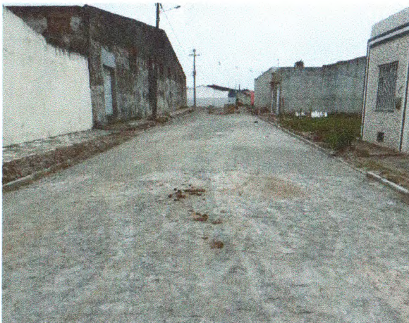
PAVIMENTAÇÃO NA RUA ANA SOUZA DE JESUS
