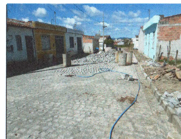
PAVIMENTAÇÃO NA RUA MAURINO JOSÉ DA SILVA
