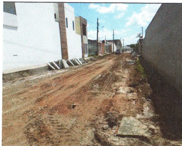
REGULARIZAÇÃO DO TERRENO
