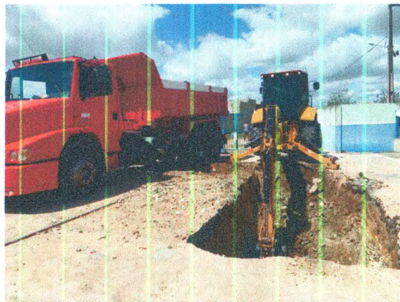
ESCAVAÇÃO; CARGA E TRANSPORTE DE ENTULHO
