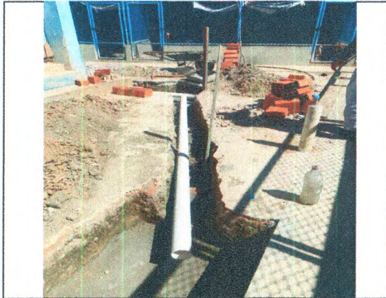
ESCAVAÇÃO; ASSENTAMENTO DE TUBO DE PVC
