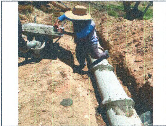
ESCAVAÇÃO; ASSENTAMENTO DE TUBO DE CONCRETO
