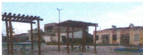
Assentamento de peças de eucalipto tratado
