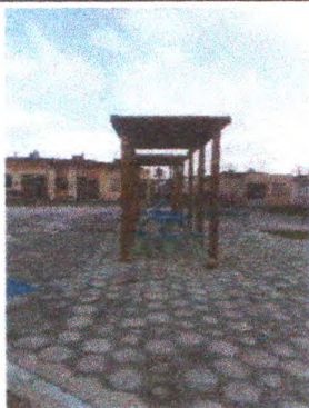
Assentamento de peças de eucalipto tratado
