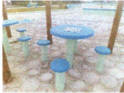
Mesa de concreto, com tabuleiro em pastilha cerâmica, base de tubo de concreto e bancos em tubo de concreto
