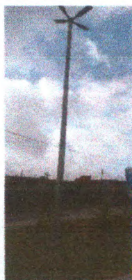
Escavação manual de vala com profundidade até 1,50m para assentamento de Poste circular de concreto (Engastamento de Poste 1 com Luminária em LED)
