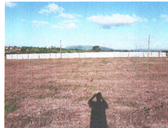
LIMPEZA MECANIZADA DO TERRENO
