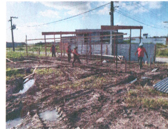
EXECUÇÃO DO BARRACÃO DE APOIO À PRODUÇÃO
