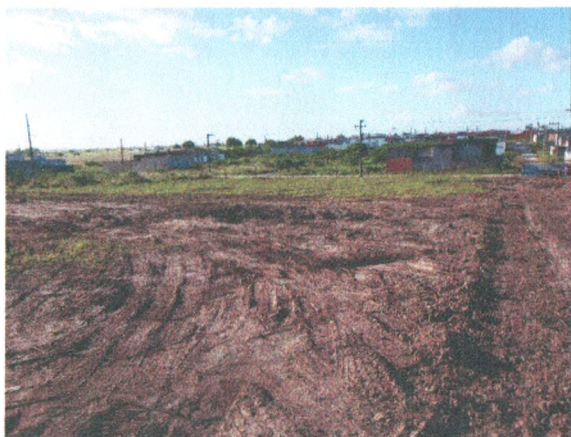
LIMPEZA MECANIZADA DO TERRENO
