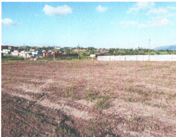
FECHAMENTO COM TELA; ASSENTAMENTO DE MEIO-FIO; ATERRO COMPACTADO
