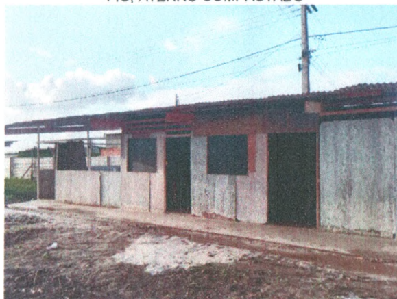
EXECUÇÃO DO BARRACÃO DE APOIO À PRODUÇÃO
