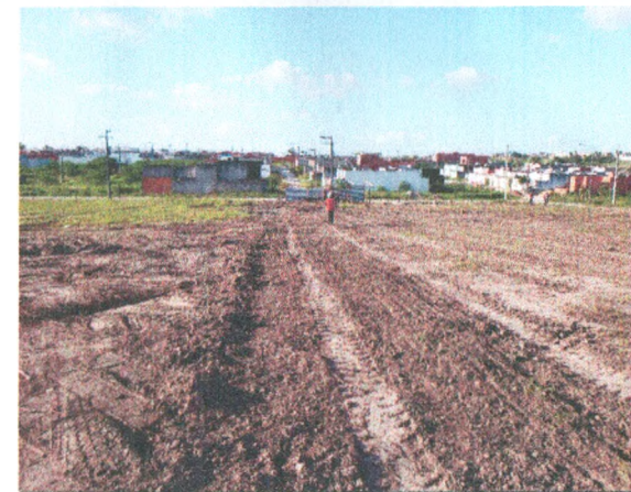
LIMPEZA MECANIZADA DO TERRENO
