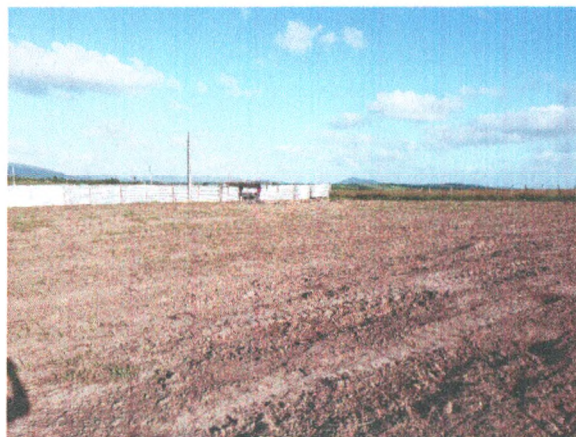
LIMPEZA MECANIZADA DO TERRENO
