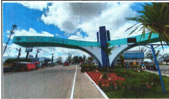
PLACA DE OBRA, PINTURA DE MEIO-FIO, PINTURA DO PÓRTICO
