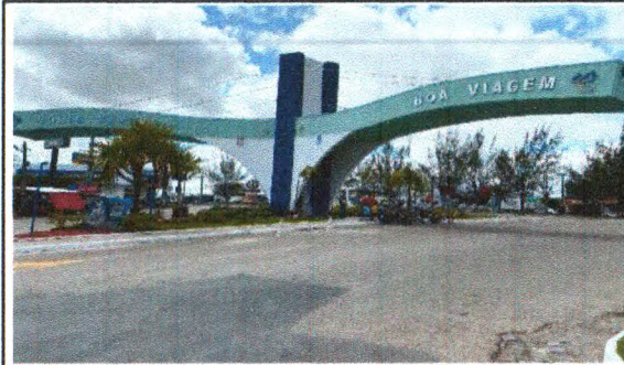
PINTURA DO PÓRTICO E PINTURA DE MEIO-FIO
