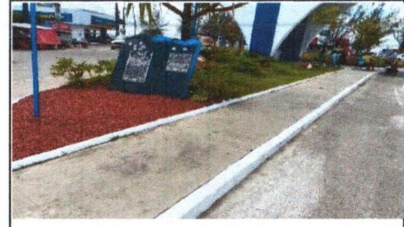
PINTURA DE MEIO-FIO
