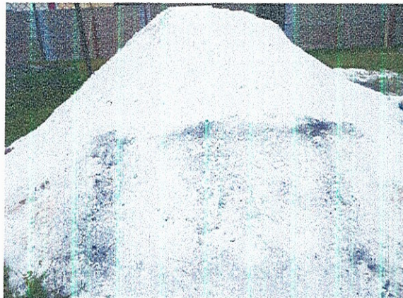
FORNECIMENTO DO COLCHÃO DE AREIA
