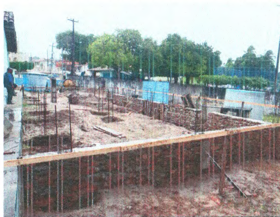
LOCAÇÃO EM GABARITO DE MADEIRA; ALVENARIA DE PEDRA ARGAMASSADA; SAPATAS E ARRANQUES
