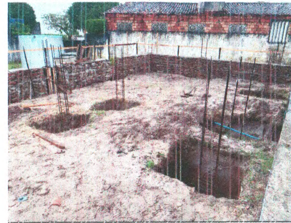
LOCAÇÃO EM GABARITO DE MADEIRA; ALVENARIA DE PEDRA ARGAMASSADA; ESCAVAÇÃO; SAPATAS E ARRANQUES; ATERRO COMPACTADO
