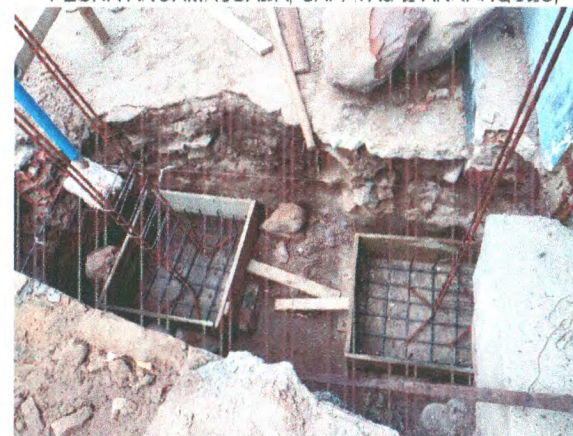
ESCAVAÇÃO; SAPATAS E ARRANQUES EM CONCRETO ARMADO
