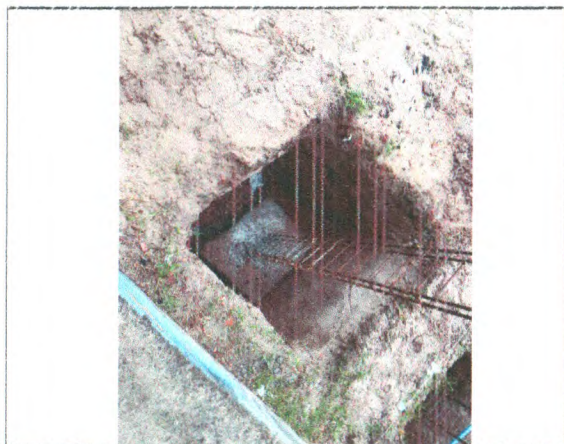
ESCAVAÇÃO; SAPATAS E ARRANQUES EM CONCRETO ARMADO; ATERRO COMPACTADO
