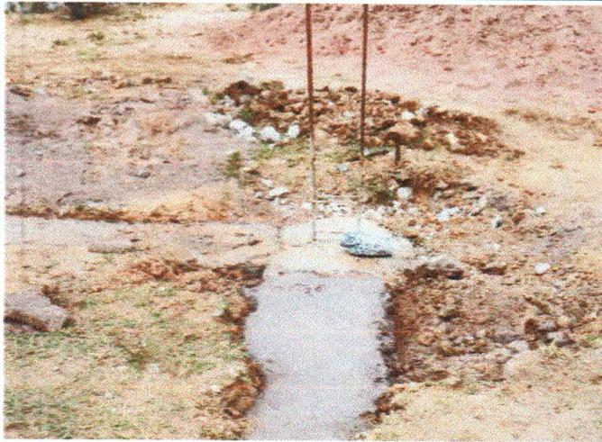
ALVENARIA DE PEDRA / SAPATA / ARRANQUE DE PILAR
