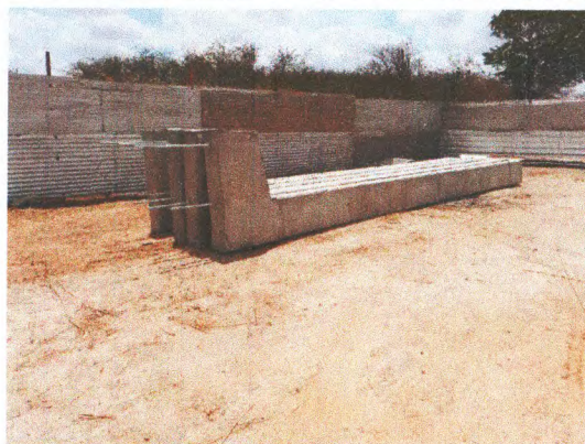
ESTRUTURA PARA GALPÃO PRÉ-MOLDADO
