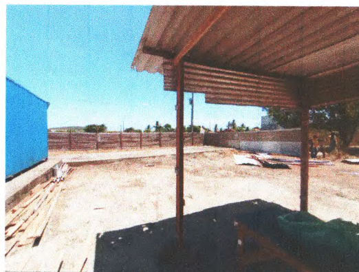
LOCAÇÃO DE CONSTRUÇÃO
