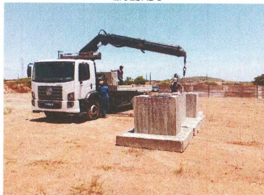
ESTRUTURA PARA GALPÃO PRÉ-MOLDADO
