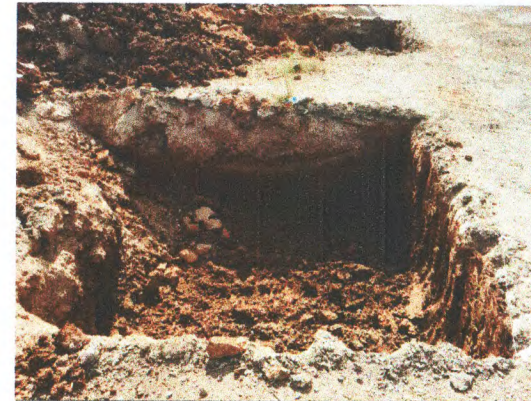
ESCAVAÇÃO PRA ESTRUTURA PRA GALPÃO PRÉ-MOLDADO
