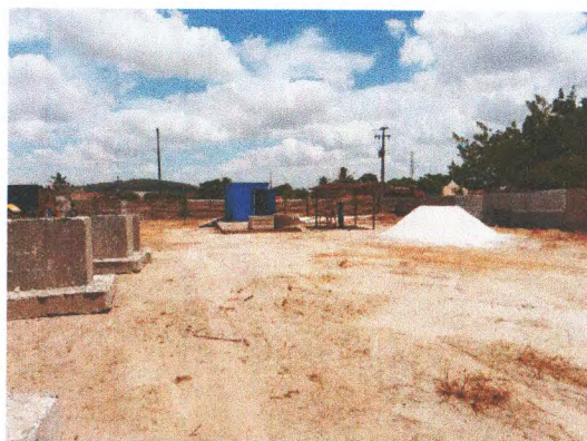
LOCAÇÃO COM PIQUETES DE MADEIRA
