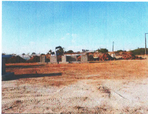
ESTRUTURA PARA GALPÃO PRÉ-MOLDADO
