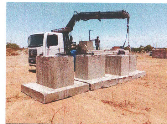
ESTRUTURA PARA GALPÃO PRÉ-MOLDADO
