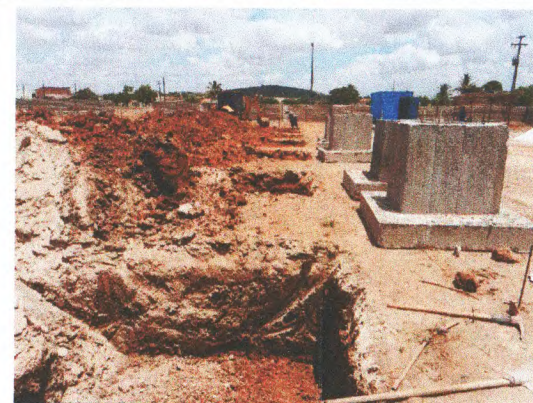
ESCAVAÇÃO PRA ESTRUTURA PRA GALPÃO PRÉ-MOLDADO
