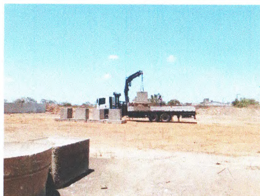
ESTRUTURA PARA GALPÃO PRÉ-MOLDADO
