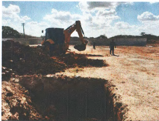
ESCAVAÇÃO PRA ESTRUTURA PRA GALPÃO PRÉ-MOLDADO
