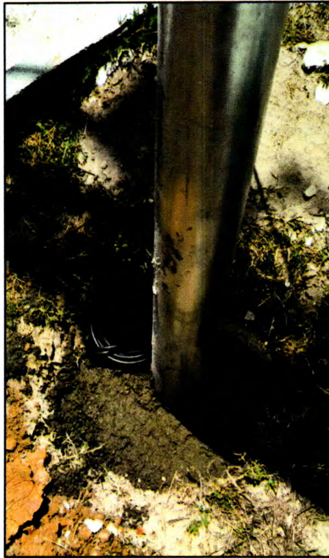
Figura 9: Concretagem de poste
