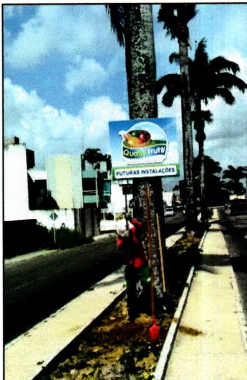
Figura 2: Escavação manual de buraco
