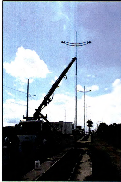
Figura 13: Concretagem de poste
