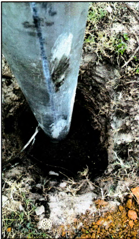
Figura 8: Concretagem de poste
