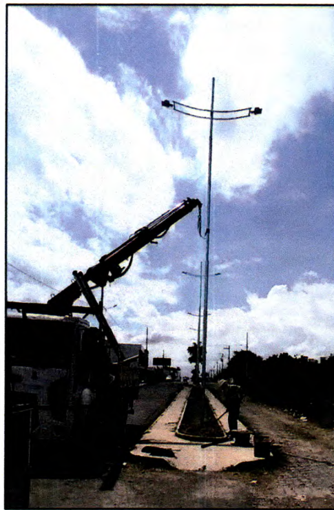
Figura 11: Implantação de Poste
