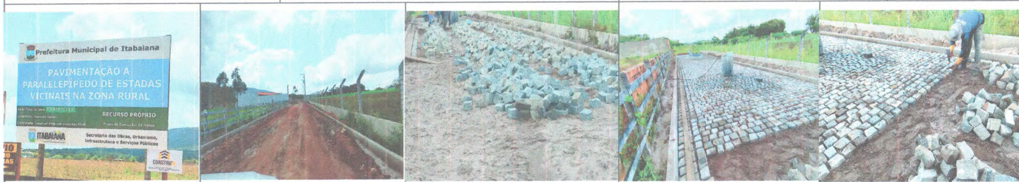
PLACA DE OBRA ASSENTAMENTO DO MEIO FIO E REGULARIZAÇÃO DO TERRENO ✓ COLCHÃO DE AREIA ✓ ASSENTAMENTO DAS PEDRAS ✓ ASSENTAMENTO DAS PEDRAS ✓
