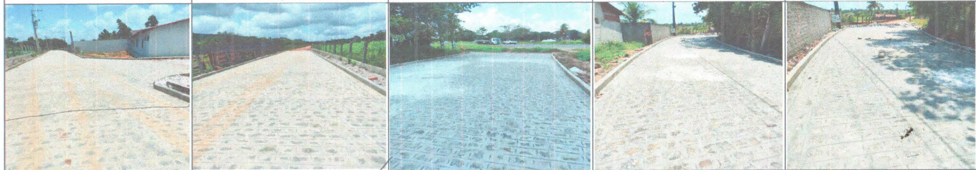
PAVIMENTO PRONTO - TRECHO 1 - CASA DAS IRMÃS PAVIMENTO PRONTO - TRECHO 1 - CASA DAS IRMÃS ✓ PAVIMENTO PRONTO-TRECHO 2 PROXIMO A BR-235 ✓ PAVIMENTO PRONTO-TRECHO 2 PROXIMO A BR-235 ✓ PAVIMENTO PRONTO-TRECHO 2 PROXIMO A BR-235 ✓
