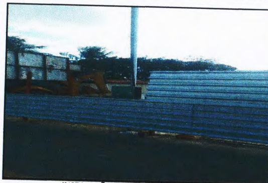
INSTALAÇÕES PROVISÓRIA DE ENERGIA
