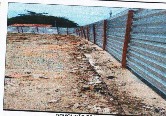
DEMOLIÇÃO DE MEIO FIO
