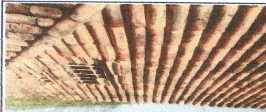
Revisão em cobertura com telha cerâmica tipo canal comum, Itabalana ou similar, com reposição de 20% do material.
