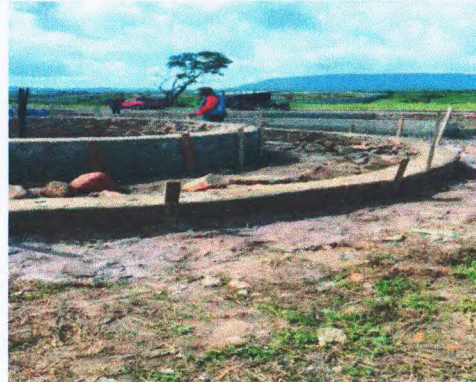
ESCAVAÇÃO, CARGA, TRANPORTE E ALVENARIA DE PEDRA - ROTATÓRIA 02
