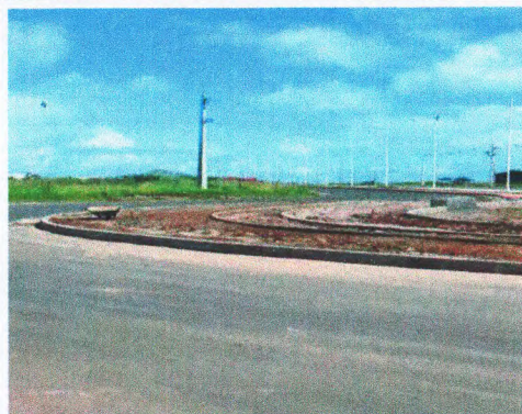
ASSENTAMENTO DE MEIO-FIO - ROTATÓRIA 02
