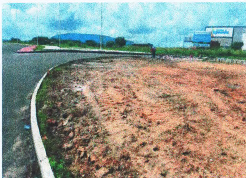
LIMPEZA E REGULARIZAÇÃO DE ÁREA - ROTATÓRIA 01
