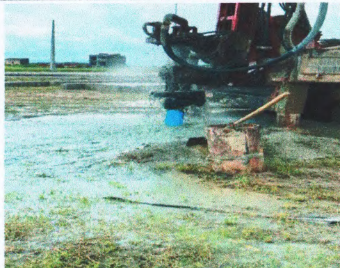
PERFURAÇÃO E REVESTIMENTO DE POÇOS ARTESIANOS
