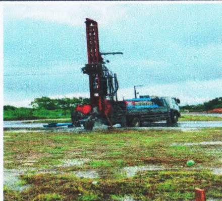
PERFURAÇÃO E REVESTIMENTO DE POÇOS ARTESIANOS
