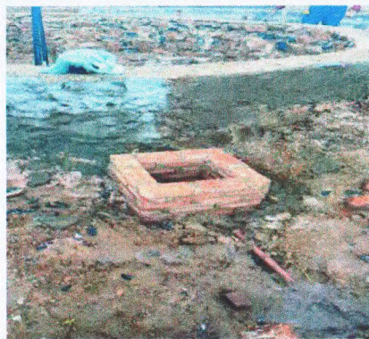
ALVENARIA DE PEDRA
