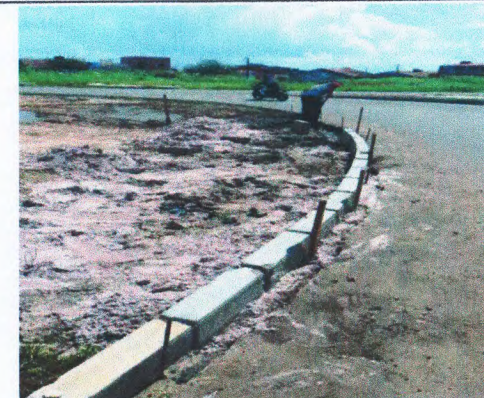
ASSENTAMENTO DE MEIO-FIO - ROTATÓRIA 01
