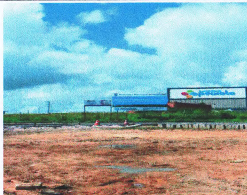
LIMPEZA E REGULARIZAÇÃO DE ÁREA - ROTATÓRIA 01
