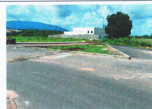
ASSENTAMENTO DE MEIO-FIO - ROTATÓRIA 02
