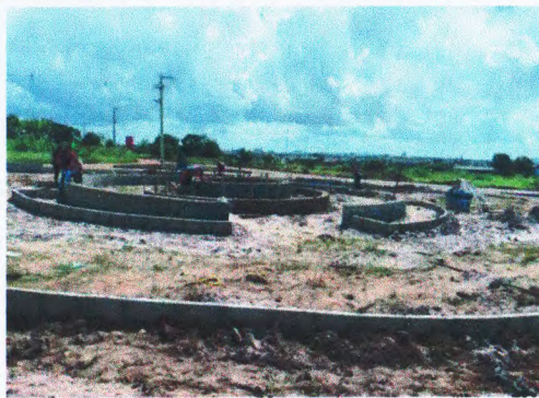
ESCAVAÇÃO, CARGA, TRANPORTE E ALVENARIA DE PEDRA - ROTATÓRIA 02
