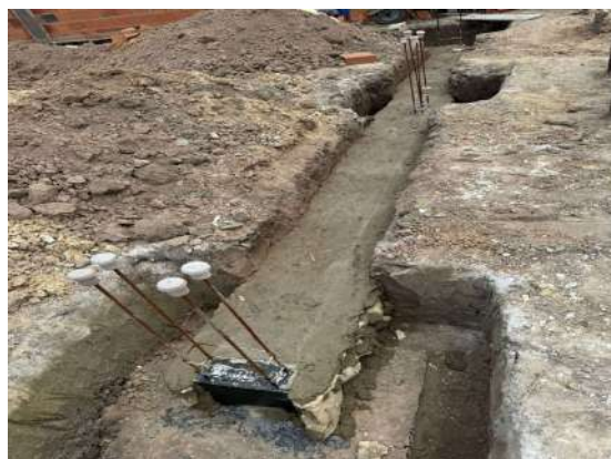
ESCAVAÇÃO, ATERRO, ALVENARIA DE PEDRA
