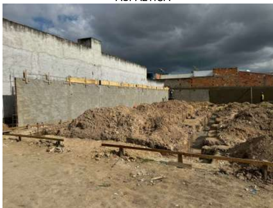
ESCAVAÇÃO, ATERRO, ALVENARIA DE PEDRA E LASTRO DE CONCRETO
