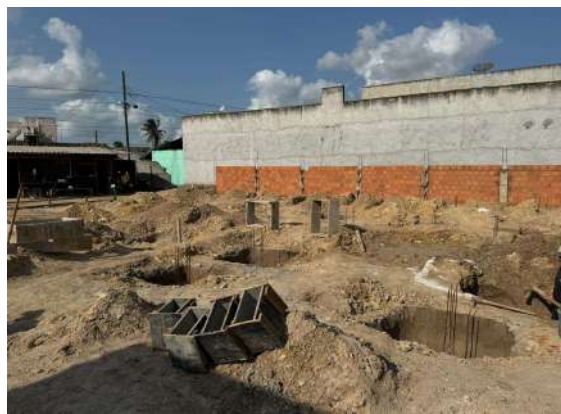
ESCAVAÇÃO E ATERRO
