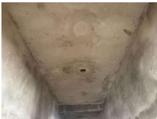
CHAPISCO E REBOCO
