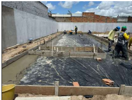
LONA PLÁSTICA E EXECUÇÃO DA CAMADA IMPERMEABILIZADORA
