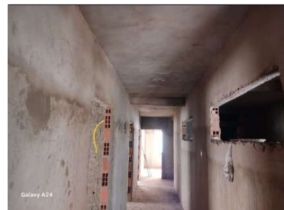
CHAPISCO E REBOCO
