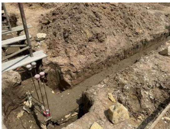
ESCAVAÇÃO, ATERRO, ALVENARIA DE PEDRA
