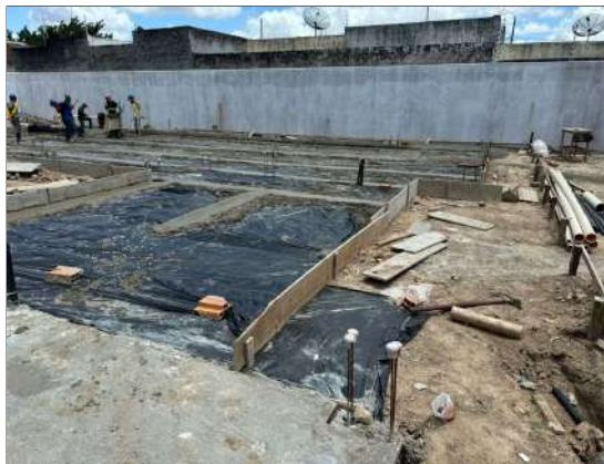
LONA PLÁSTICA E EXECUÇÃO DA CAMADA IMPERMEABILIZADORA
