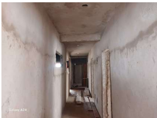
CHAPISCO E REBOCO
