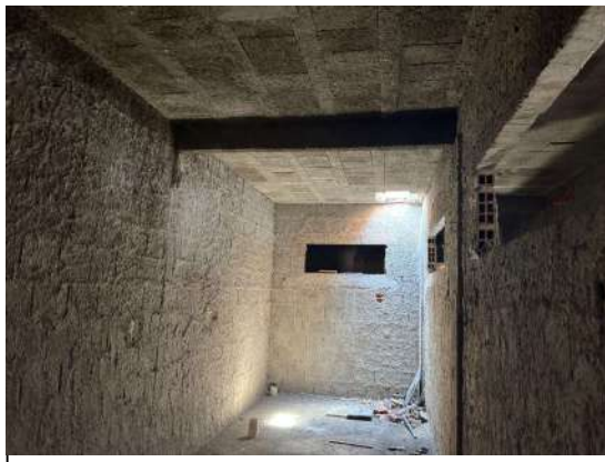
CHAPISCO E REBOCO
