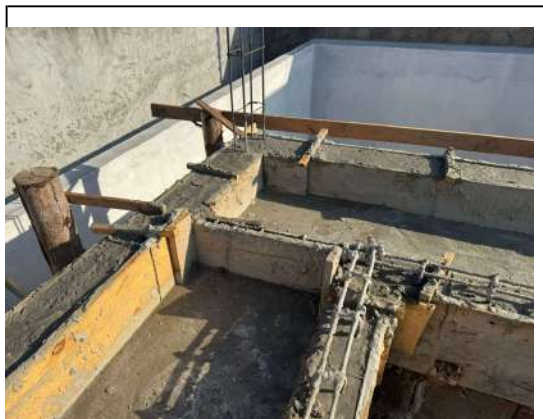
LAJE MACIÇA E VIGAS SUPERIORES
