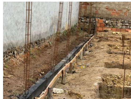
ESCAVAÇÃO, CONCRETO ARMADO E PINTURA ASFÁLTICA
