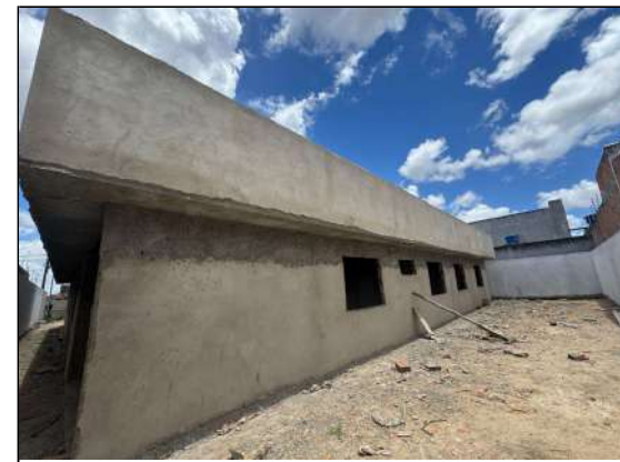
CHAPISCO E REBOCO
