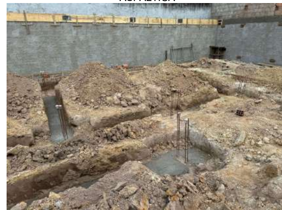
ESCAVAÇÃO, ATERRO, ALVENARIA DE PEDRA E LASTRO DE CONCRETO
