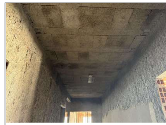
CHAPISCO E REBOCO
