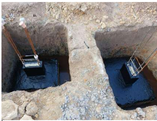
ESCAVAÇÃO, CONCRETO ARMADO E PINTURA ASFÁLTICA
