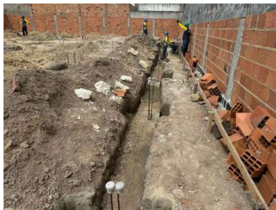
ESCAVAÇÃO, ATERRO, ALVENARIA DE PEDRA
