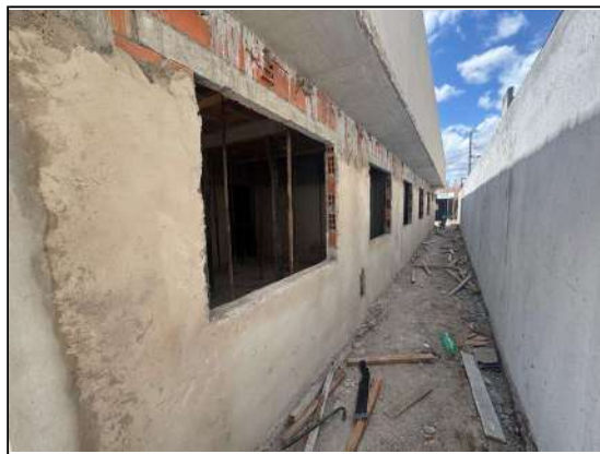
CHAPISCO E REBOCO
