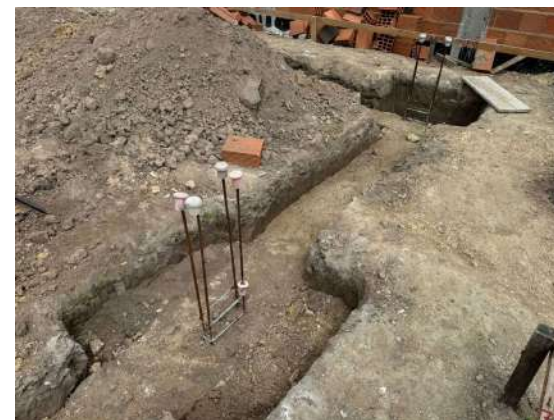
ESCAVAÇÃO, ATERRO, ALVENARIA DE PEDRA
