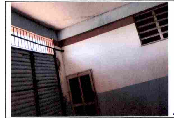
REPARO E CORTE EM ESQUADRIA
