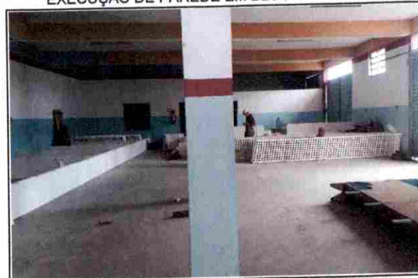
EXECUÇÃO DE PAREDE EM BLOCO DE GESSO
