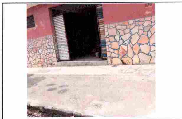
EXECUÇÃO DE PASSEIO
