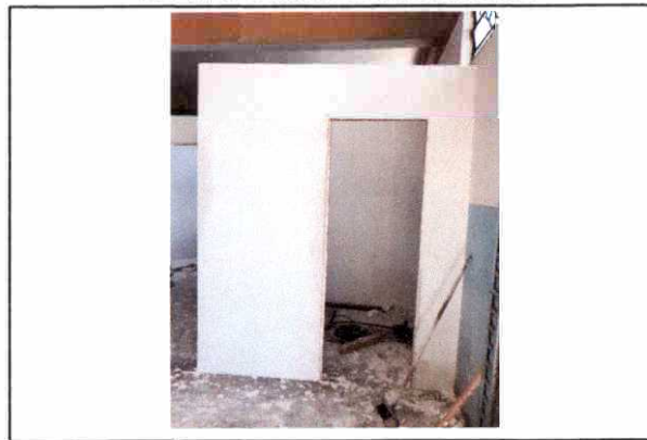
EXECUÇÃO DE PAREDE EM BLOCO DE GESSO
