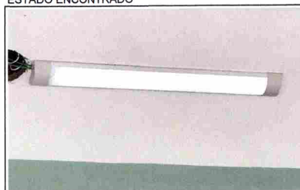
INSTALAÇÃO DE LUMINÁRIA
