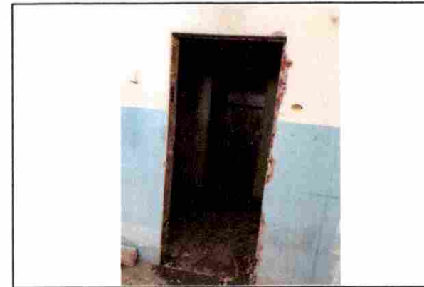
INSTALAÇÃO DE CAIXÕES
