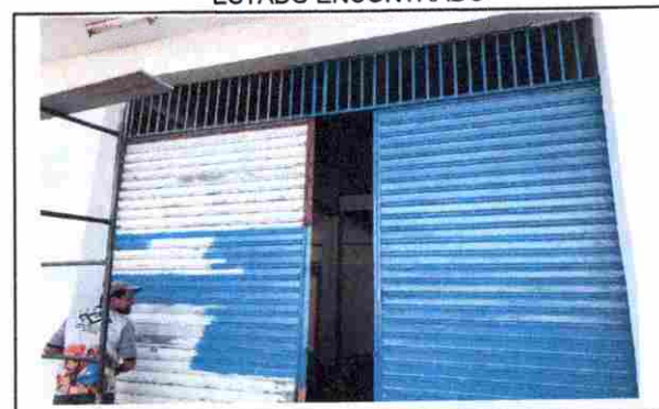
PINTURA COM ESMALTE SINTÉTICO
