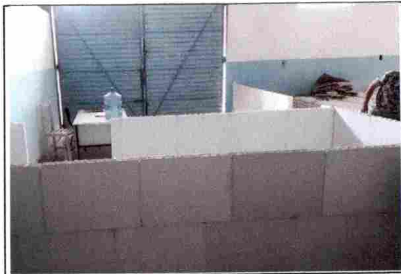
EXECUÇÃO DE PAREDE EM BLOCO DE GESSO
