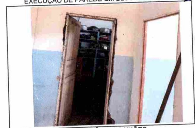
INSTALAÇÃO DE CAIXÕES
