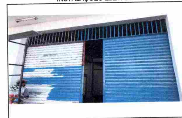
PINTURA COM ESMALTE SINTÉTICO
