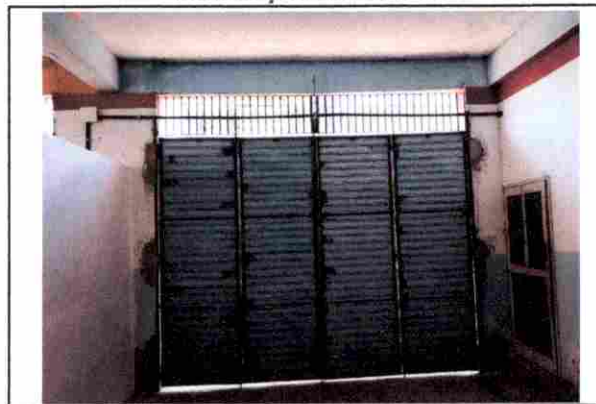
REPARO E CORTE EM ESQUADRIA
