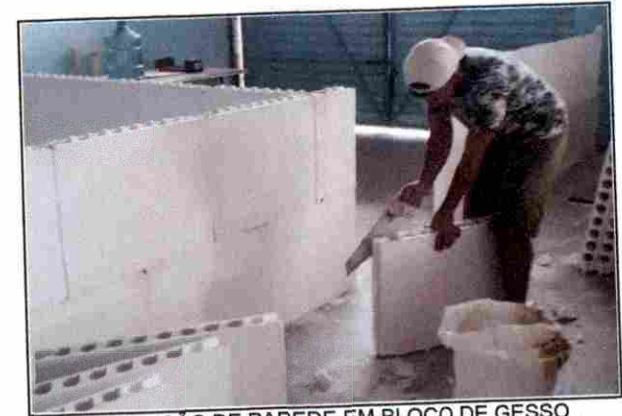
EXECUÇÃO DE PAREDE EM BLOCO DE GESSO
