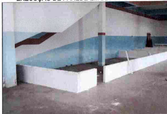
EXECUÇÃO DE PAREDE EM BLOCO DE GESSO
