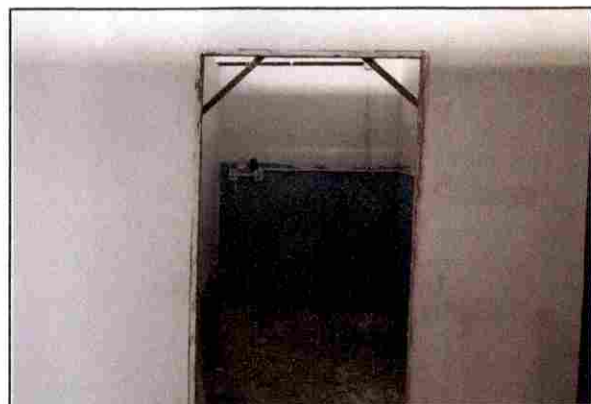
INSTALAÇÃO DE CAIXÕES
