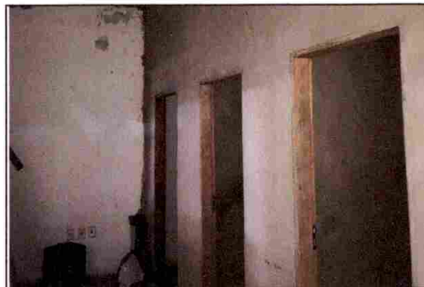
INSTALAÇÃO DE CAIXÕES
