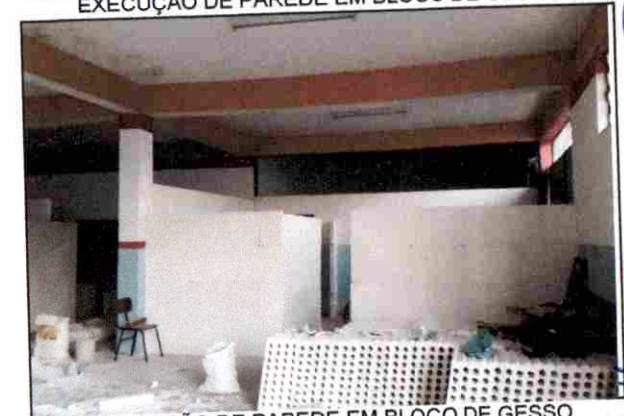
EXECUÇÃO DE PAREDE EM BLOCO DE GESSO
