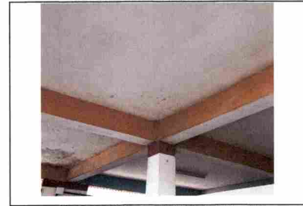
EMASSAMENTO COM MASSA CORRIDA
