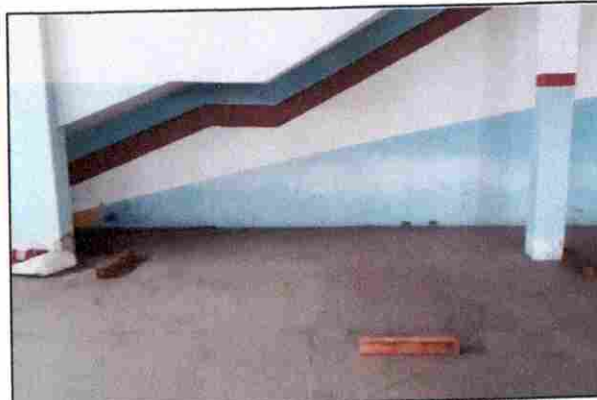
EXECUÇÃO DE PAREDE EM BLOCO DE GESSO
