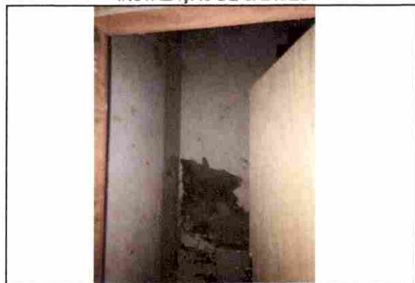
INSTALAÇÃO DE CAIXÕES
