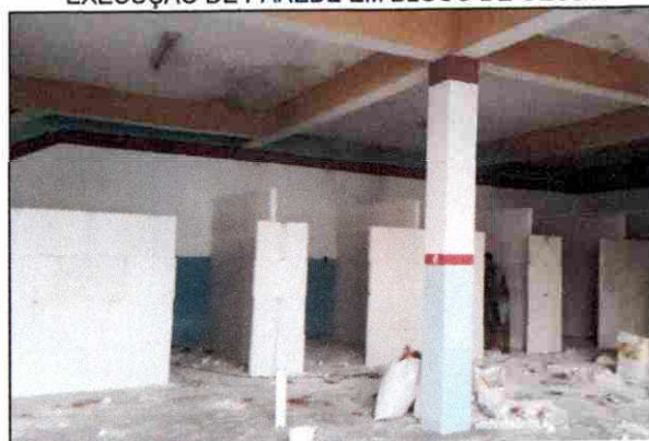
EXECUÇÃO DE PAREDE EM BLOCO DE GESSO
