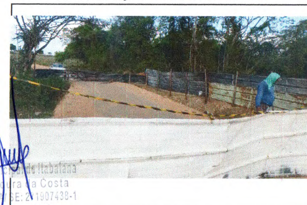
TAPUME DE OBRA
