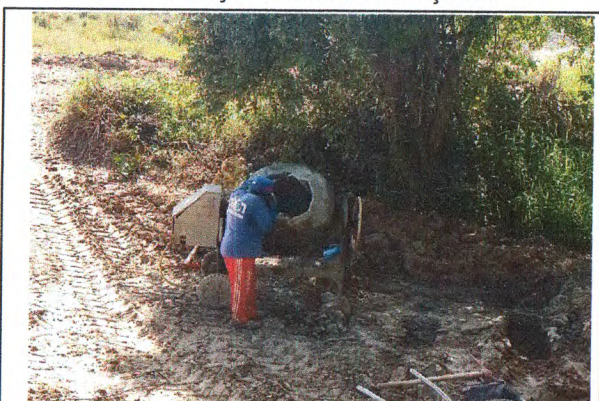
MOBILIZAÇÃO DE EQUIPE EM OBRA
