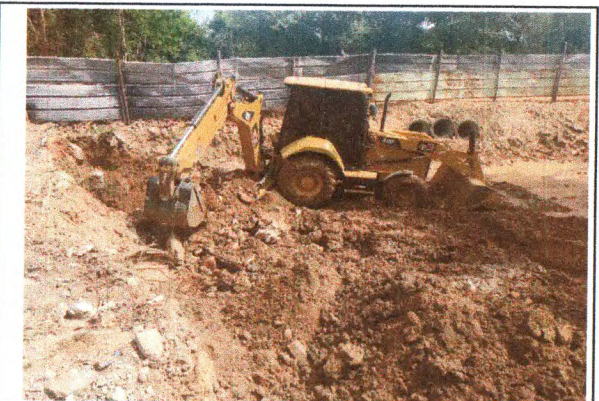
ESCAVAÇÕES DAS FUNDAÇÕES
