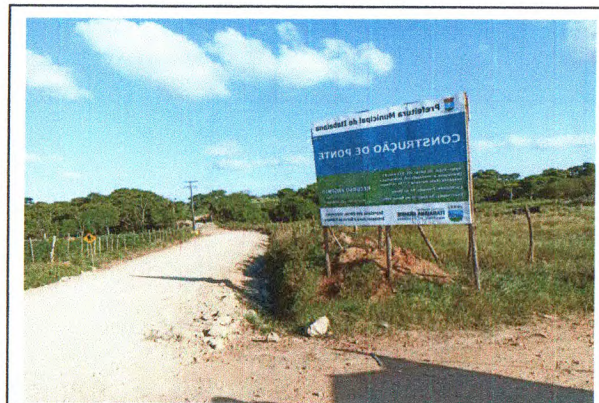
INSTALAÇÃO DA PLACA DE OBRA
