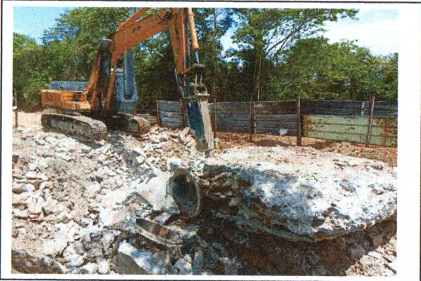
DEMOLIÇÃO DE PONTE EXISTENTE
