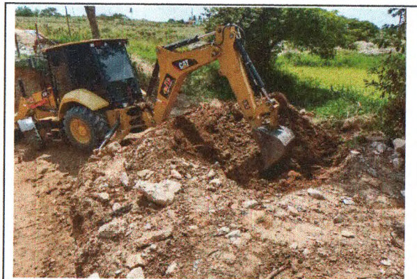
ESCAVAÇÕES DAS FUNDAÇÕES
