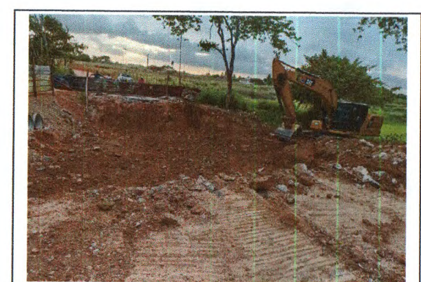
DEMOLIÇÃO DE PONTE EXISTENTE
