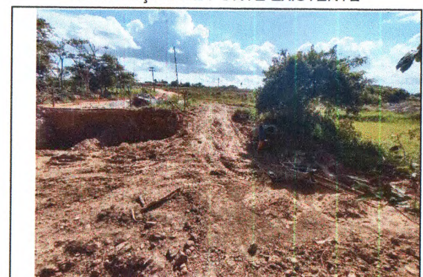
ESCAVAÇÕES DAS FUNDAÇÕES
