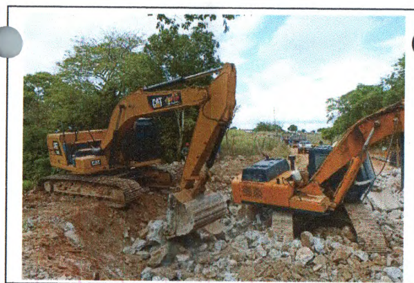
DEMOLIÇÃO DE PONTE EXISTENTE
