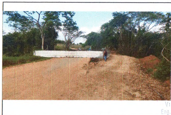
TAPUME DE OBRA
