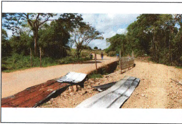
TAPUME DE OBRA
