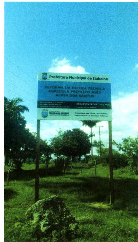
Foto 01. Instalação da placa da obra
