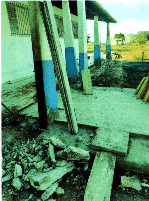
Foto 07. Remoção de passeio externo.
