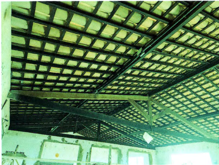
Foto 11. Retelamento após a limpeza realizada e aplicação de produto em todo madeiramento
