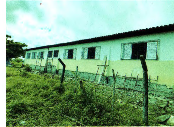
Foto 08. Início da demolição de reboco externo danificado e demolição de passeio. Esquadrias metálicas instaladas e grades das janelas pintadas.
