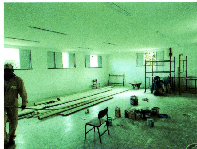
Foto 18. Auditório com todo o gesso já instalado, emassado e pintado. Esquadrias metálicas instaladas e luminárias instaladas, bem como tomadas. Paredes emassadas e com uma demão de tinta.
