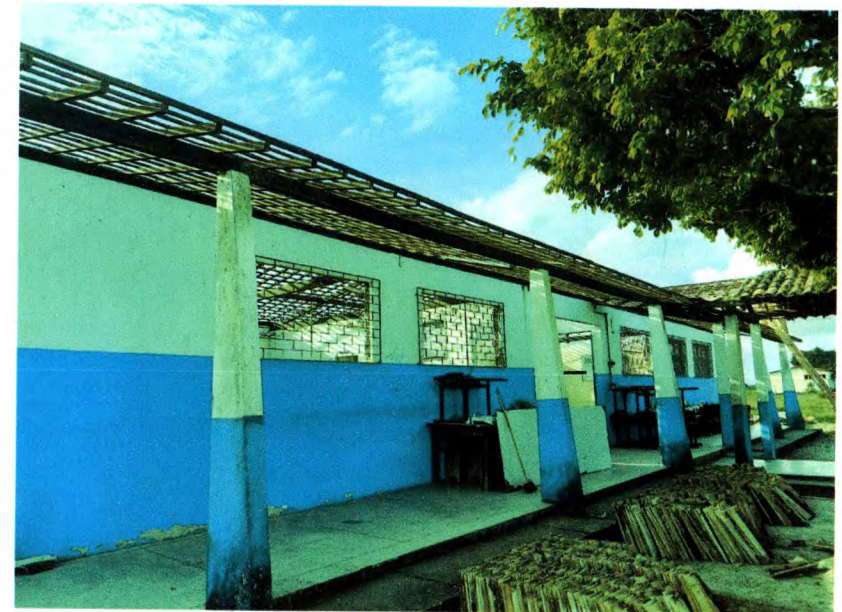
Foto 05. Remoção das telhas cerâmicas para limpeza e revisão do madeiramento do telhado. Remoção de forro de gesso.
