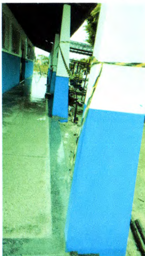
Foto 40. Pintura externa e piso de alta resistência polido
