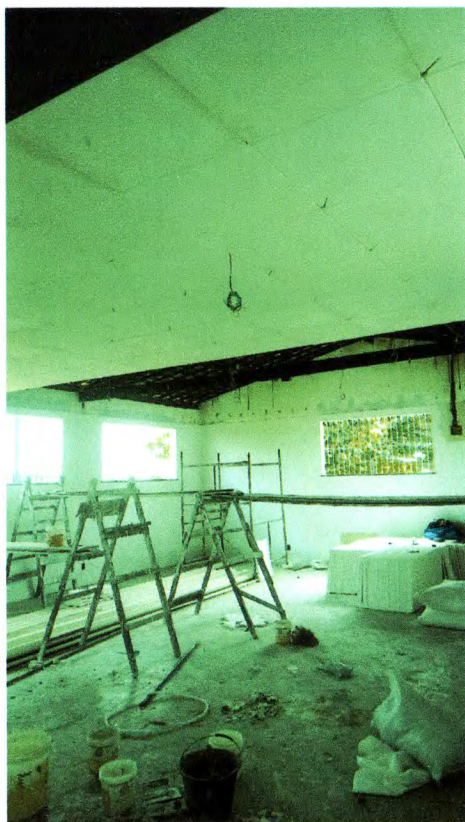
Foto 17. Instalação de novo forro em placas de gesso
