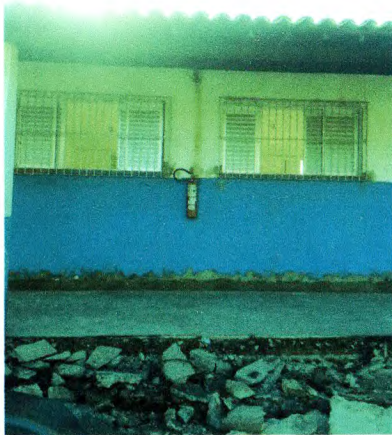
Foto 25. Instalação de novas esquadrias em alumínio e pintura de grades
