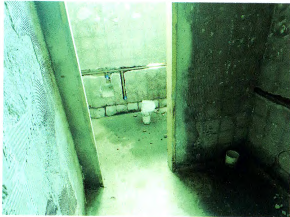
Foto 02. Remoção de piso e revestimento cerâmico dos banheiros com a substituição de toda estrutura hidráulica e de esgoto. Remoção de antigos caixões de porta e instalação de novos
