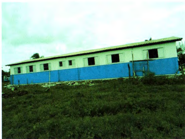
Foto 37. Pintura externa e instalação de refletores
