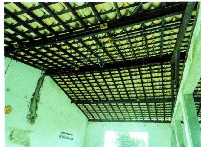
Foto 28. Substituição de eletrodutos, caixas de passagem e fiação de todos os ambientes do bloco. Instalação de pontos de energia
