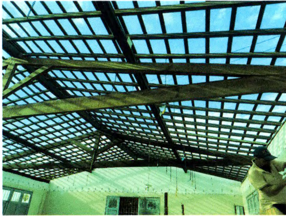
Foto 06. Remoção das telhas cerâmicas para limpeza e revisão do madeiramento do telhado. Remoção de forro de gesso.
