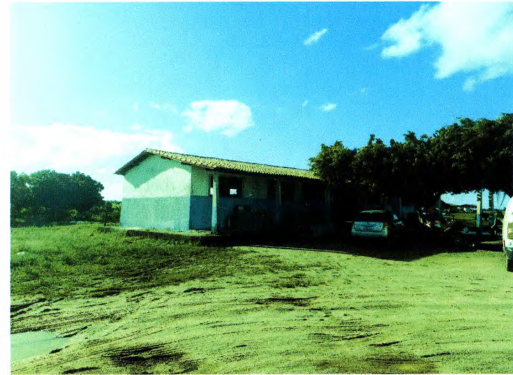
Figura 12. Telhado após a limpeza realizada
