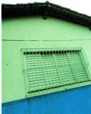
Foto 39. Pintura externa e instalação de refletores
