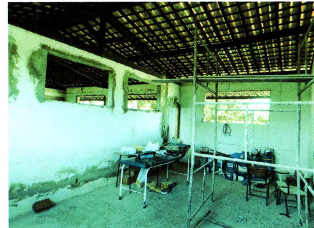
Foto 13. Retirada de esquadrias de madeiras existentes e preparação para instalação de novas esquadrias em alumínio. Instalação de caixa de porta novo
