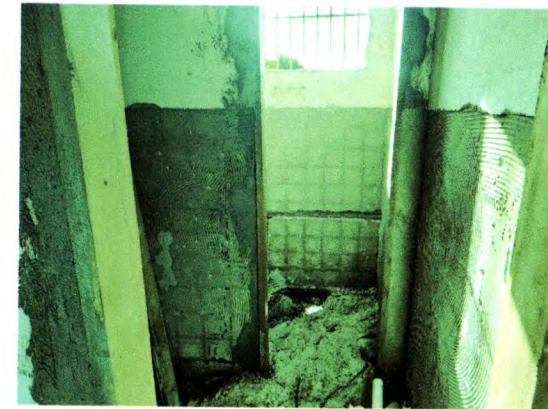
Foto 04. Remoção de piso e revestimento cerâmico dos banheiros. Remoção de antigos caixões de porta e instalação de novos
