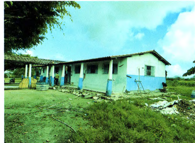
Foto 27. Emassamento de paredes externas
