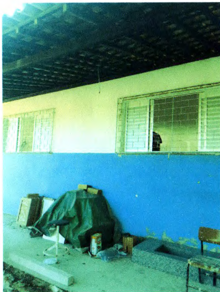
Foto 26. Instalação de novas esquadrias em alumínio e pintura de grades
