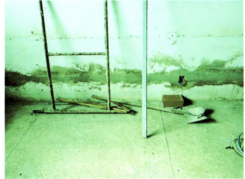
Foto 31. Substituição de eletrodutos, caixas de passagem e fiação de todos os ambientes do bloco. Instalação de pontos de energia
