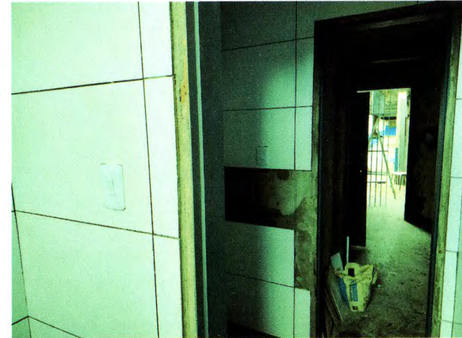
Foto 22. Novos revestimentos dos banheiros e instalação de pontos de luz
