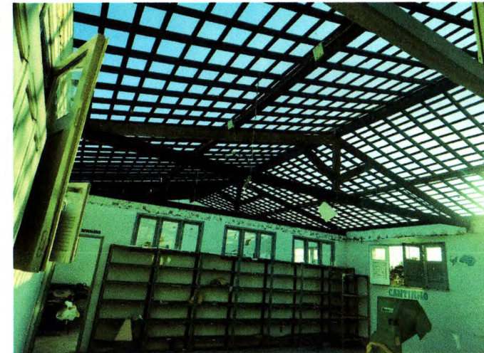
Foto 09. Madeiramento do telhado após a remoção das telhas e aplicação de anticupim
