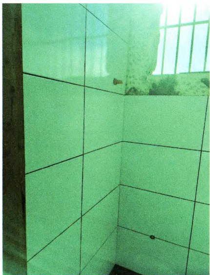
Foto 14. Instalação de revestimento nos banheiros e picotamento da parede
