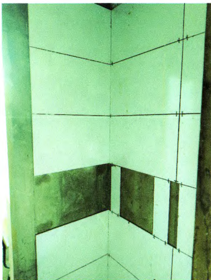
Foto 15. Instalação de revestimento nas paredes
