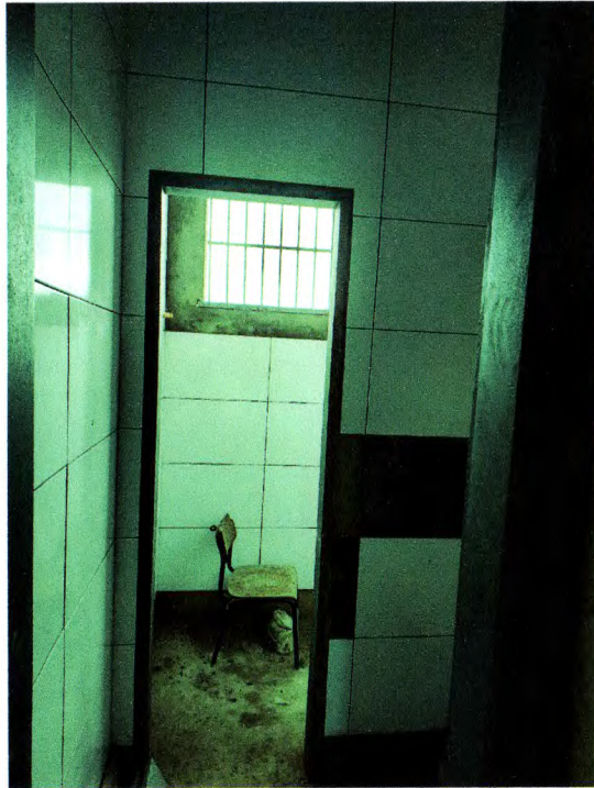
Foto 20. Revestimento do banheiro instalado.
