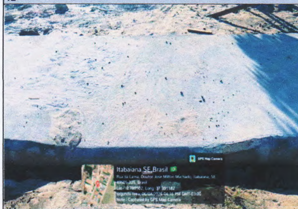
Imagem 12 - Rampa para deficiente da praça da mangabeira 02
