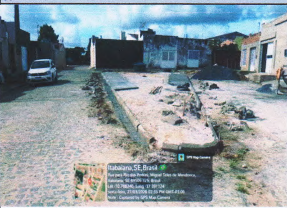
Imagem 11 - Meio-fio pré moldado de concreto simples (0,12 x 0,30 x 1,00m), rejuntado comargamassa de cimento e areia no traço 1:3
