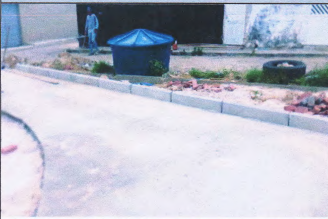
Imagem 9 - Meio fio canteiro praça 01
