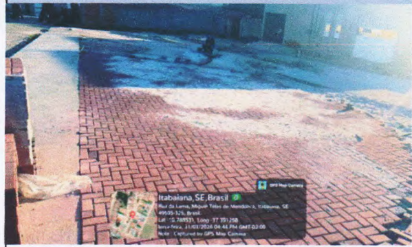
Imagem 8 - EXECUÇÃO DE PASSEIO EM PISO INTERTRAVADO, COM BLOCO RETANGULAR COLORIDO DE 20 X 10 CM, ESPESSURA 6 CM. AF_10/2022 PRAÇA 02
