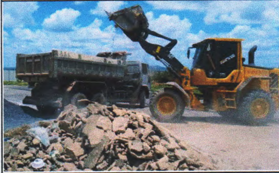
Imagem 8 - Retirada de entulho com caminhão basculante
