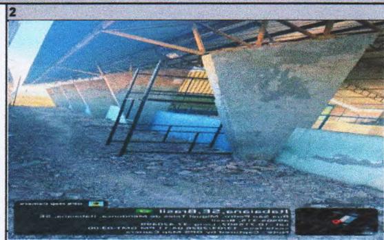
Imagem 2 - Demolição do revestimento cerâmico
