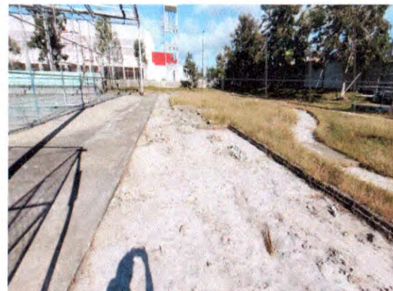
PAVIMENTAÇÃO DA PRAÇA - DEMOLIÇÃO DE CONCRETO
