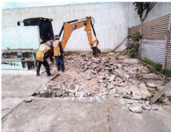
PAVIMENTAÇÃO DA PRAÇA - DEMOLIÇÃO DE CONCRETO
