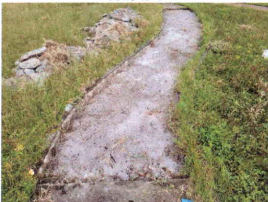
PISTA DE CAMINHADA - DEMOLIÇÃO DE CONCRETO
