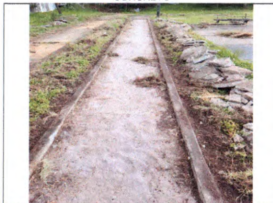
PISTA DE CAMINHADA - DEMOLIÇÃO DE CONCRETO
