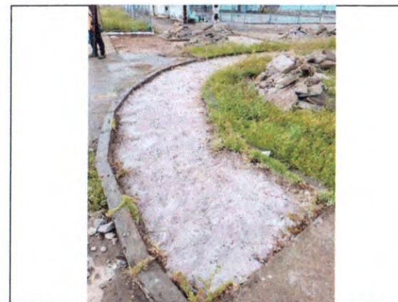
PISTA DE CAMINHADA - DEMOLIÇÃO DE CONCRETO
