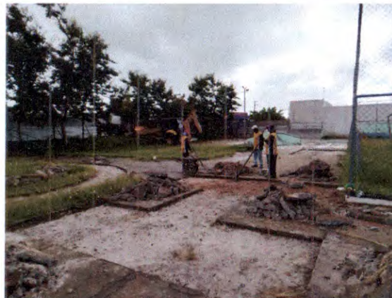
PAVIMENTAÇÃO DA PRAÇA - DEMOLIÇÃO DE CONCRETO
