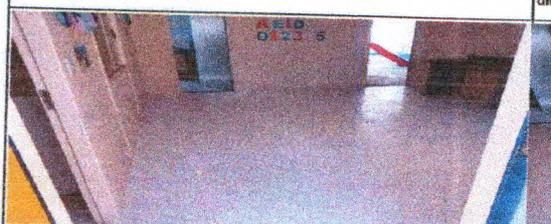
Revestimento cerâmico para piso com placas tipo esmaltada padrão popular de dimensões 35x35
