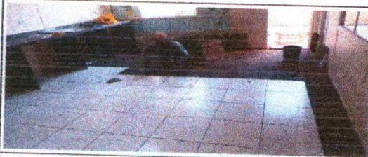
Revestimento cerâmico para piso com placas tipo esmaltada padrão popular de dimensões 35x35
