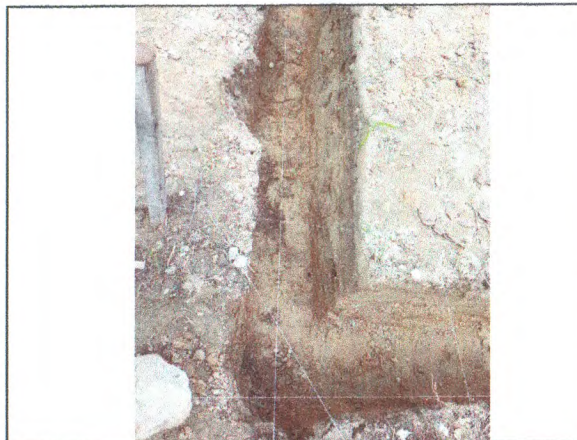
ESCAVAÇÃO DO MURO
