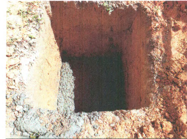
BANHEIROS - ESCAVAÇÃO DAS SAPATAS; CONCRETO MAGRO
