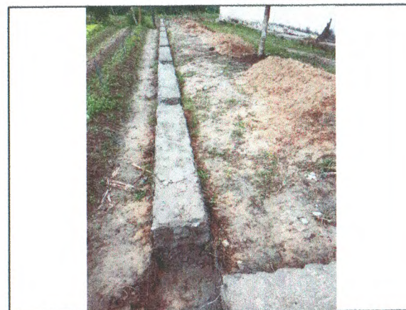
ESCAVAÇÃO DO MURO; ALVENARIA DE PEDRA ARGAMASSADA
