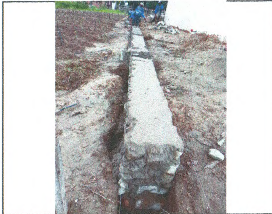
ESCAVAÇÃO DO MURO; ALVENARIA DE PEDRA ARGAMASSADA
