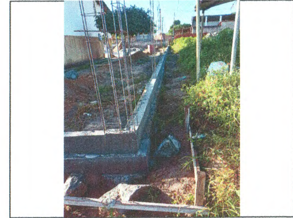
ALVENARIA DE PEDRA ARGAMASSADA; CINTAMENTO INFERIOR; FERRAGEM DOS PILARES
