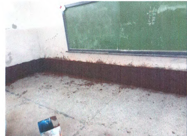
DEMOLIÇÃO DE REBOCO; CHAPISCO E REBOCO INTERNO
