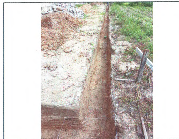
ESCAVAÇÃO DO MURO
