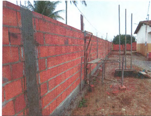
CINTAMENTO INFERIOR; PILARES EM CONCRETO ARMADO; ALVENARIA DE BLOCO
