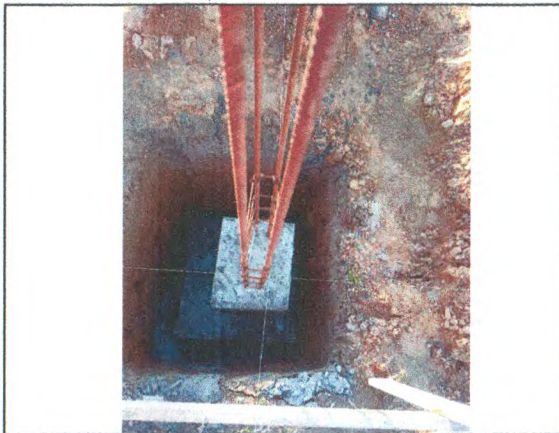
BANHEIROS - ESCAVAÇÃO; SAPATA E ARRANQUE DOS PILARES EM CONCRETO ARMADO
