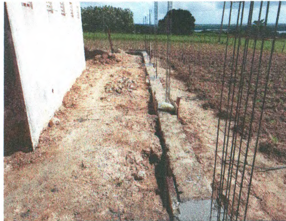
ESCAVAÇÃO DO MURO; ALVENARIA DE PEDRA ARGAMASSADA; FERRAGEM DOS PILARES
