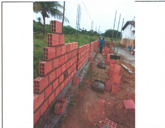
CINTAMENTO INFERIOR; FERRAGEM DOS PILARES; ALVENARIA DE BLOCO
