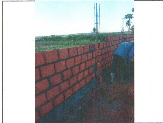
CINTAMENTO INFERIOR; FERRAGEM DOS PILARES; ALVENARIA DE BLOCO
