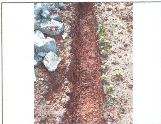
ESCAVAÇÃO DO MURO
