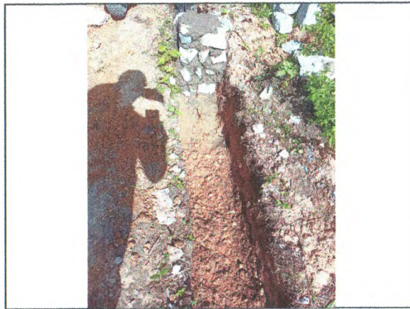
ESCAVAÇÃO DO MURO; ALVENARIA DE PEDRA ARGAMASSADA
