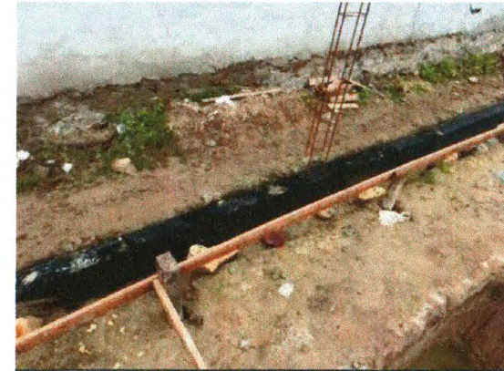
CINTA INFERIOR DO MURO E IMPERMEABILIZAÇÃO
