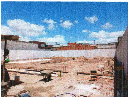
PINTURA DO MURO
