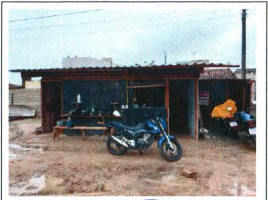
BARRAÇÃO DA OBRA
