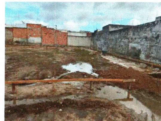
MOVIMENTO DE TERRA E LOCAÇÃO DA OBRA
