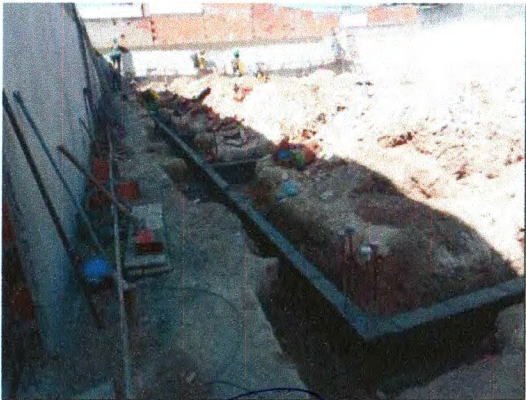
IMPERMEABILIZAÇÃO DO BALDRAME
