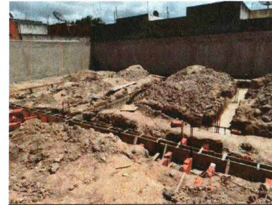
REBOCO E VIGAS BALDRAME
