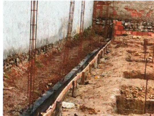
CINTA INFERIOR DO MURO E IMPERMEABILIZAÇÃO
