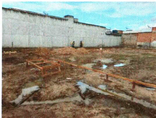
MOVIMENTO DE TERRA E LOCAÇÃO DA OBRA
