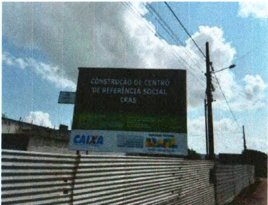
PLACA DA OBRA E TAPUME
