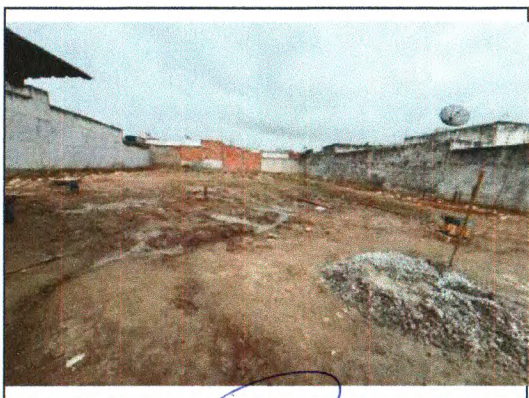
MOVIMENTO DE TERRA E LOCAÇÃO DA OBRA
