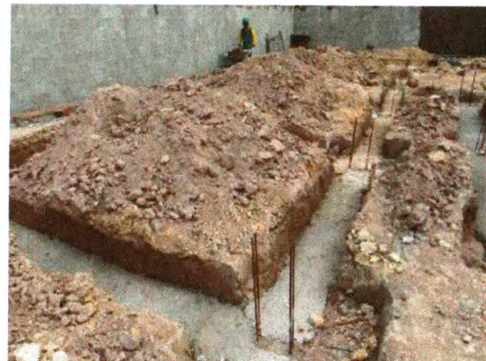
ESCAVAÇÃO E CHAPISCO
