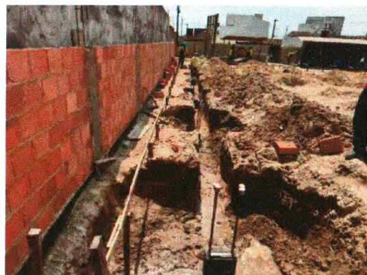
ELEVAÇÃO DO MURO E ESCAVAÇÃO
