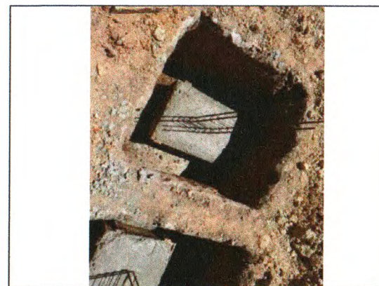
ESCAVAÇÃO E SAPATAS
