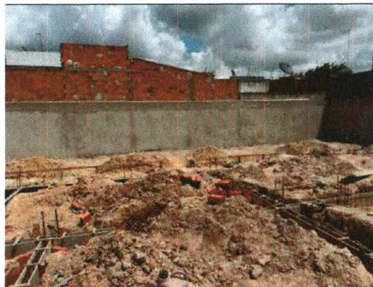
REBOCO DO MURO E VIGAS BALDRAME
