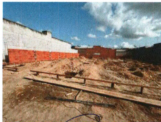
ELEVAÇÃO DO MURO E ESCAVAÇÃO
