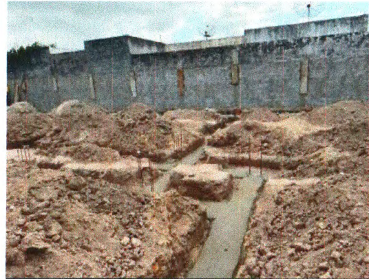
ESCAVAÇÃO E CHAPISCO
