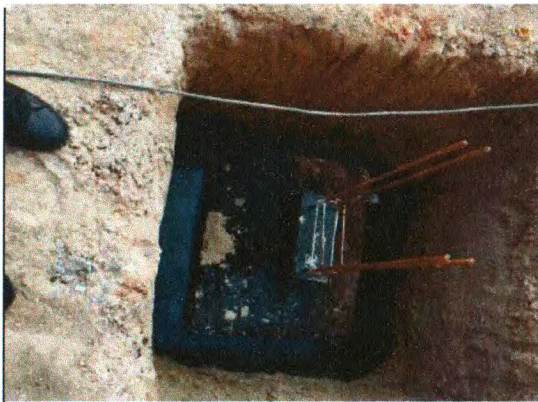
ESCAVAÇÃO, SAPATAS E IMPERMEABILIZAÇÃO
