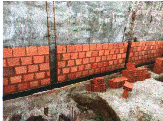
CINTA INFERIOR DO MURO, ELEVÇÃO E IMPERMEABILIZAÇÃO
