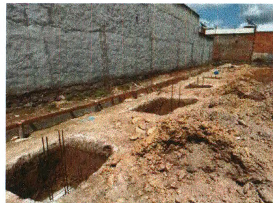
ESCAVAÇÃO, CINTA INFERIOR DO MURO E SAPATAS
