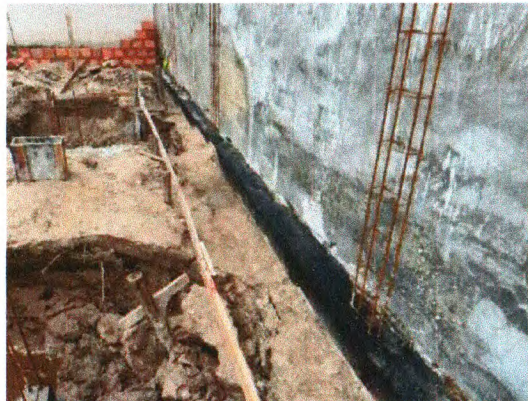
CINTA INFERIOR DO MURO E IMPERMEABILIZAÇÃO
