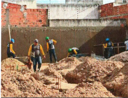
REBOCO DO MURO
