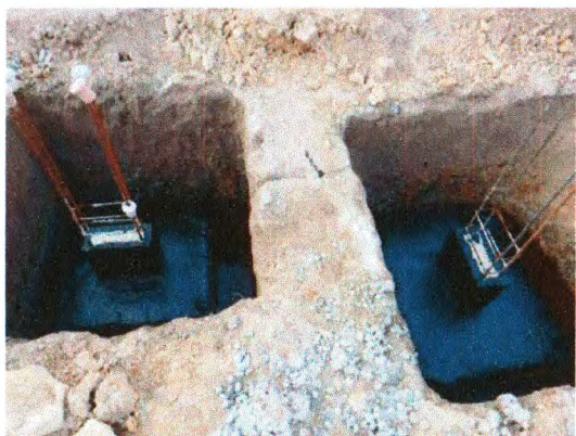
ESCAVAÇÃO, SAPATAS E IMPERMEABILIZAÇÃO
