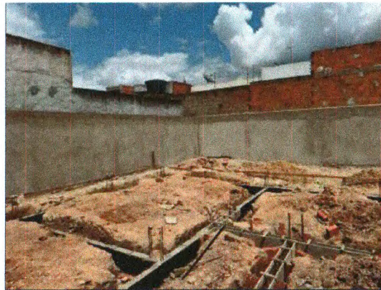
REBOCO DO MURO E VIGAS BALDRAME COM IMPERMEABILIZAÇÃO
