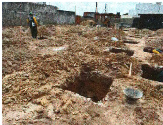
ESCAVAÇÃO E SAPATAS
