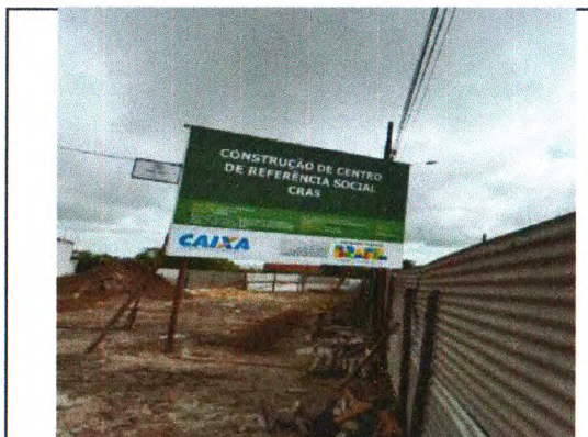
PLACA DA OBRA E TAPUME
