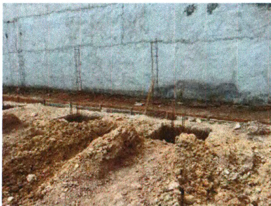
ESCAVAÇÃO, CINTA INFERIOR DO MURO E SAPATAS
