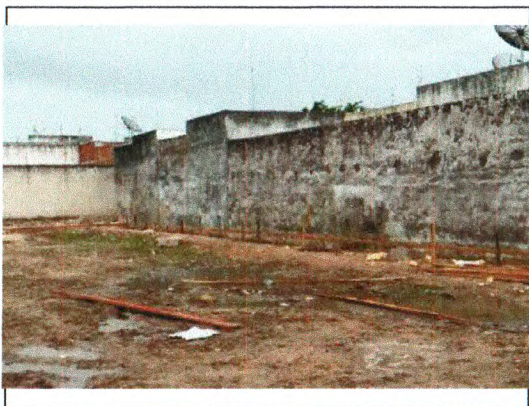
MOVIMENTO DE TERRA E LOCAÇÃO DA OBRA
