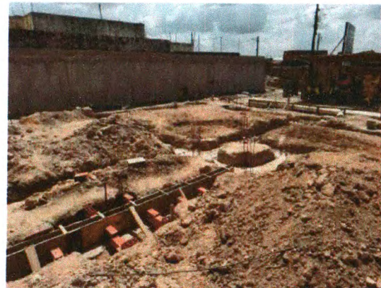
CHAPISCO E ESCAVAÇÃO
