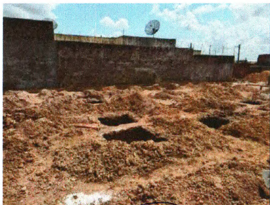
ESCAVAÇÃO E SAPATAS
