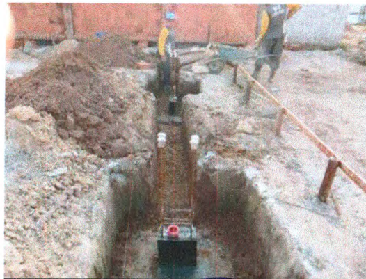
ESCAVAÇÃO E SAPATAS
