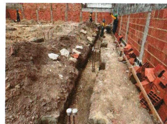
ELEVAÇÃO DO MURO E ESCAVAÇÃO
