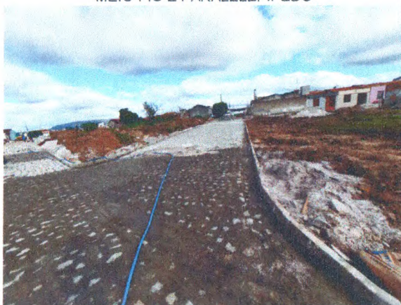
RUA QUINTINO DA SILVA NUNES - ASSENTAMENTO MEIO-FIO E PARALELEPÍPEDO
