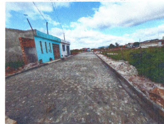
RUA PROJETADA B - ASSENTAMENTO MEIO-FIO E PARALELEPÍPEDO
