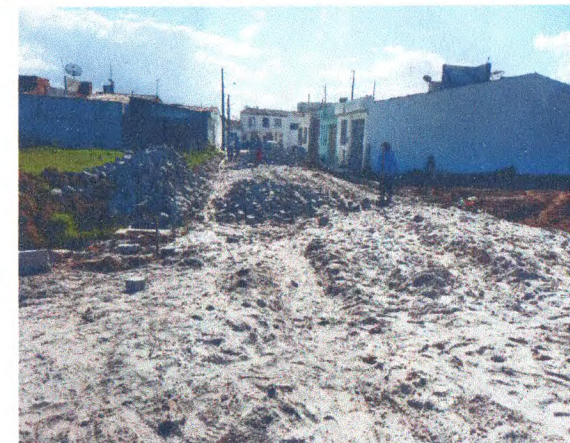
RUA QUINTINO DA SILVA NUNES - COLCHÃO DE AREIA; ASSENTAMENTO MEIO-FIO E PARALELEPÍPEDO
