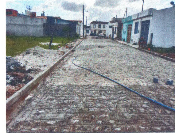
RUA PROJETADA B - ASSENTAMENTO MEIO-FIO E PARALELEPÍPEDO
