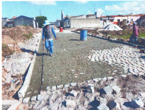
RUA QUINTINO DA SILVA NUNES - ASSENTAMENTO MEIO-FIO E PARALELEPÍPEDO; DRENAGEM SUPERFICIAL
