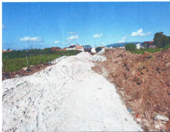
RUA PROJETADA B - REGULARIZAÇÃO DO TERRENO; COLCHÃO DE AREIA
