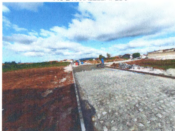
RUA PROJETADA B - ASSENTAMENTO MEIO-FIO E PARALELEPÍPEDO
