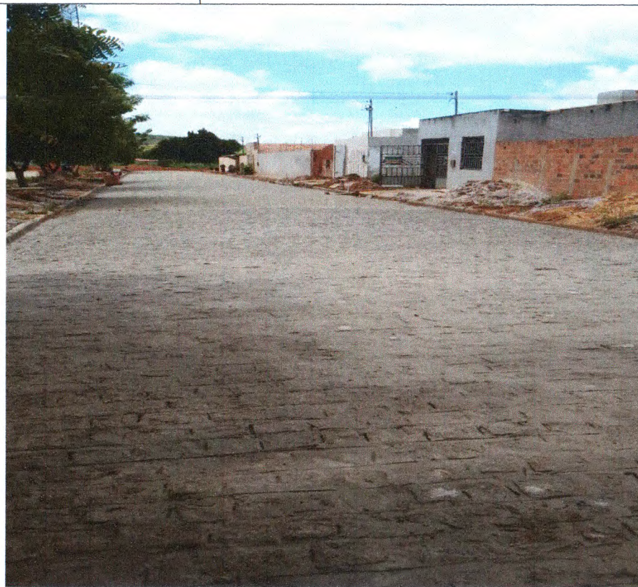
PAVIMENTAÇÃO NA AVENIDA PROJETADA
