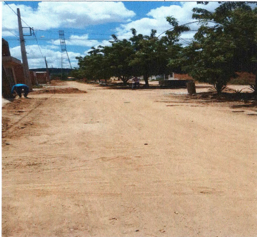
REGULARIZAÇÃO NA AVENIDA PROJETADA
