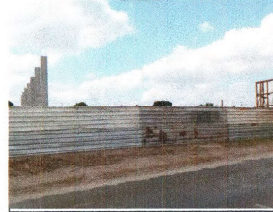
TAPUME EM TELHA METÁLICA
