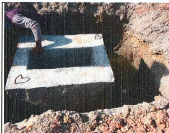
ESCAVAÇÃO E GALPÃO PRÉ MOLDADO
