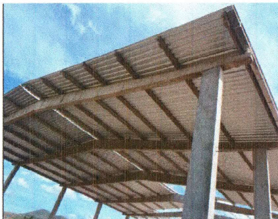
TELHAMENTO - GALPÃO PRÉ MOLDADO
