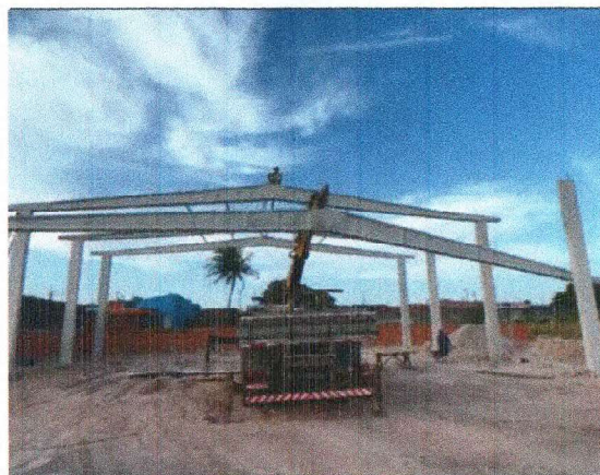
ASSENTAMENTO DAS VIGAS E TERÇAS - GALPÃO PRÉ MOLDADO
