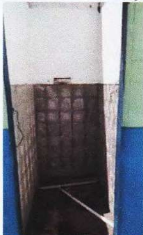
01.01.003.007 - Demolição de revestimento cerâmico ou azulejo
