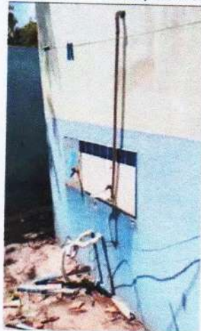
01.01.003.013 - Remoção de louças, de forma manual, sem reaproveitamento. af_09/2023
