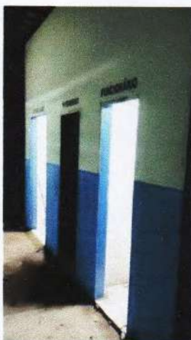
01.01.003.002 - Remoção de portas, de forma manual, sem reaproveitamento. af_09/2023
