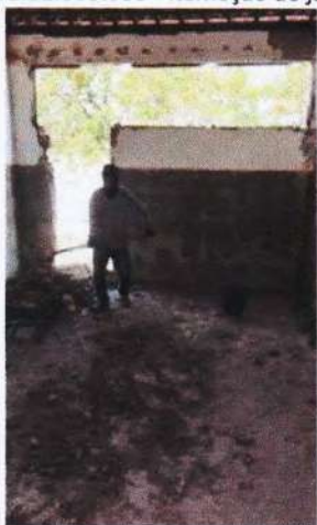
01.01.003.003 - Remoção de janelas, de forma manual, sem reaproveitamento. af_09/2023
