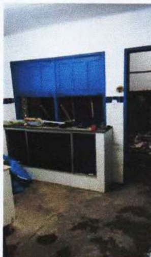
01.01.003.004 - Demolição de alvenaria de bloco cerâmico e=0,09m - revestida
