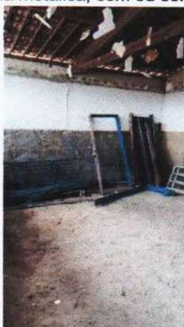
01.01.003.010 - Remoção de esquadria metálica, com ou sem reaproveitamento Rev. 01 - 03/2022
