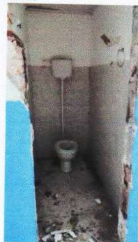
01.01.003.014 - Remoção de vaso sanitário
