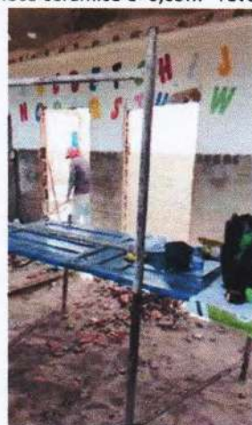
01.01.003.004 - Demolição de alvenaria de bloco cerâmico e=0,09m - revestida
