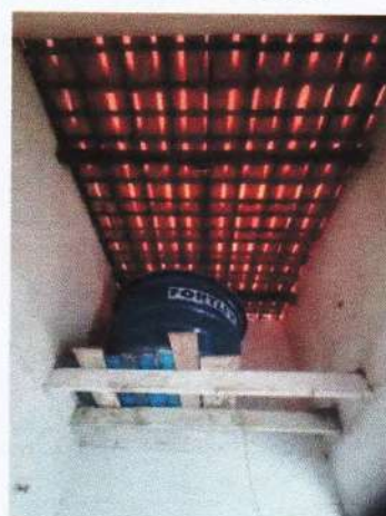
01.01.003.011 - Remoção, lavagem, carga e retelhamento de telhas cerâmicas tipo canal comum, fixadas c/ grampo de arame galv. nº 14, c/ ré-aproveitamento de 80%, Itabaiana ou similar
