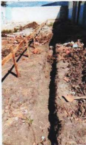
01.01.002.002 - Locação de construção de edificação até 200m2, inclusive execução de gabarito de madeira
