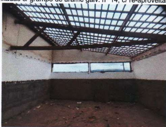
01.01.003.011 - Remoção, lavagem, carga e retelhamento de telhas cerâmicas tipo canal comum, fixadas c/ grampo de arame galv. nº 14, c/ ré-aproveitamento de 80%, Itabaiana ou similar
