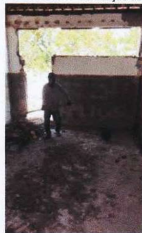
01.01.003.004 - Demolição de alvenaria de bloco cerâmico e=0,09m - revestida
