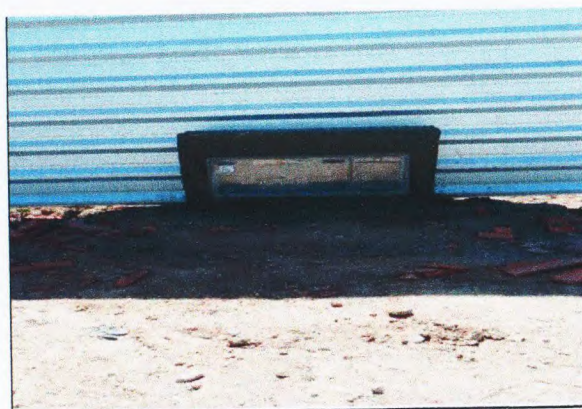
INST. DE ÁGUA E TAPUME METÁLICO
