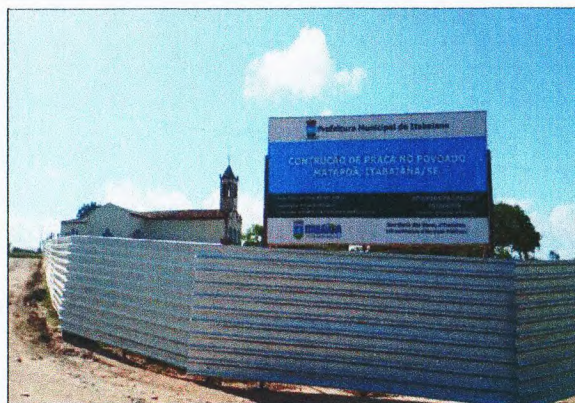
/PLACA DA OBRA E TAPUME METÁLICO
