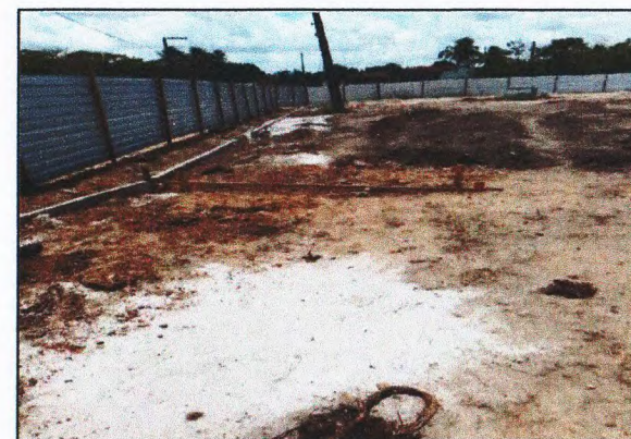
ATERRO E MEIO-FIO
