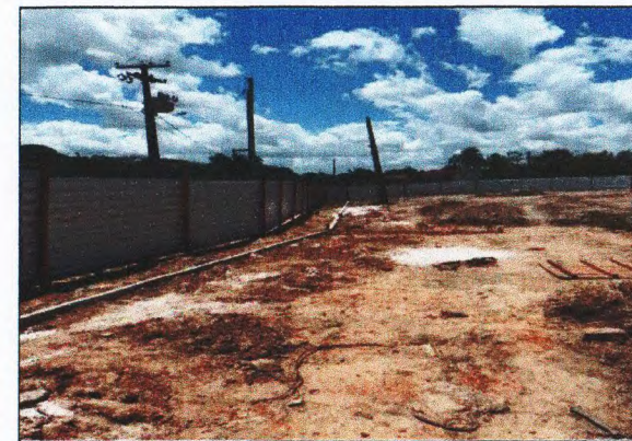
LIMPEZA DO TERRENO E TAPUME METÁLICO
