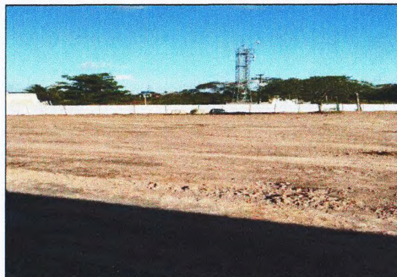
LIMPEZA DO TERRENO E TAPUME METÁLICO
