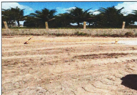
/LIMPEZA DO TERRENO
