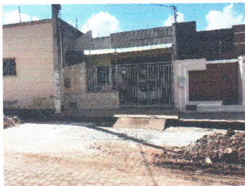
AVENIDA DR. JOSÉ MILTON MACHADO
