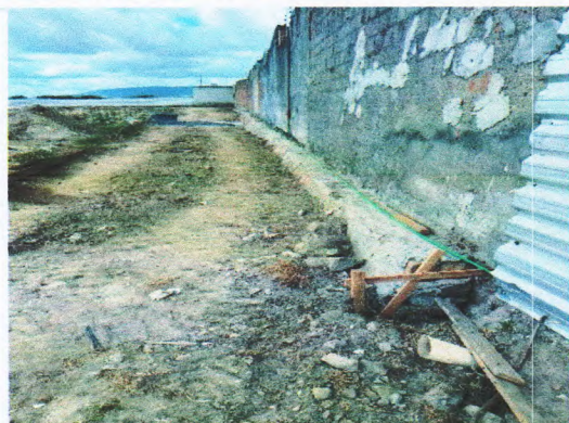
ALVENARIA DE PEDRA CALCARÉA (Coordenadas, comentários, etc.)
