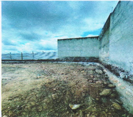
ALVENARIA DE PEDRA CALCARÉA (Coordenadas, comentários, etc.)
