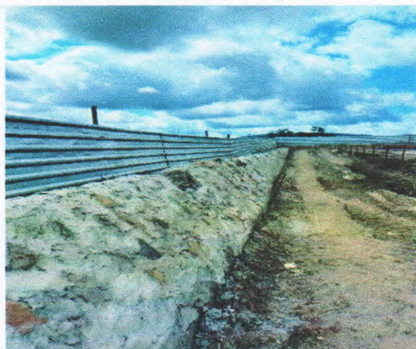
ALVENARIA DE PEDRA CALCARÉA (Coordenadas, comentários, etc.)
