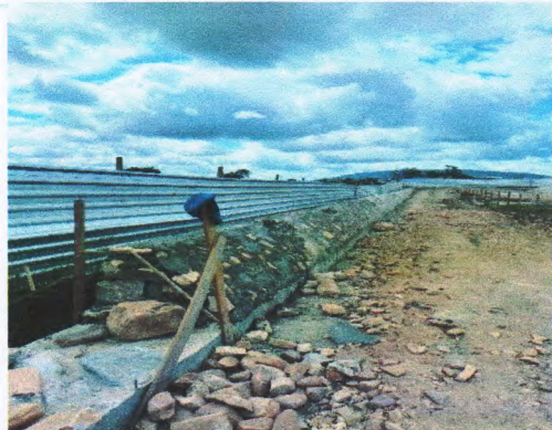
ALVENARIA DE PEDRA CALCARÉA (Coordenadas, comentários, etc.)
