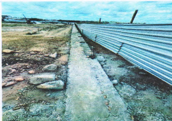
ALVENARIA DE PEDRA CALCARÉA (Coordenadas, comentários, etc.)
