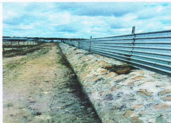
ALVENARIA DE PEDRA CALCARÉA (Coordenadas, comentários, etc.)
