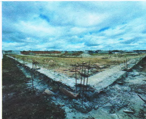
ALVENARIA DE PEDRA CALCARÉA (Coordenadas, comentários, etc.)
