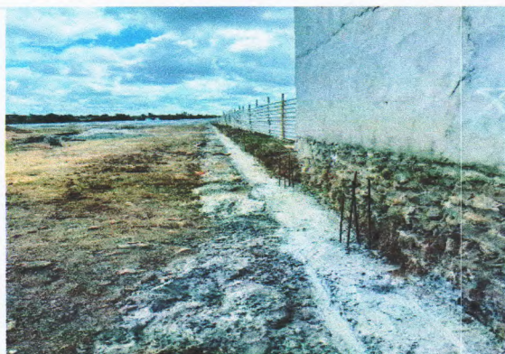
ALVENARIA DE PEDRA CALCARÉA (Coordenadas, comentários, etc.)
