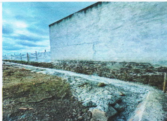
ALVENARIA DE PEDRA CALCARÉA (Coordenadas, comentários, etc.)
