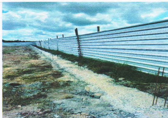
ALVENARIA DE PEDRA CALCARÉA (Coordenadas, comentários, etc.)
