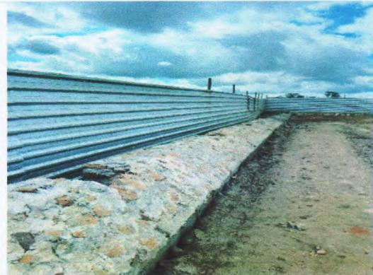
ALVENARIA DE PEDRA CALCARÉA (Coordenadas, comentários, etc.)
