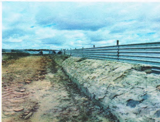
ALVENARIA DE PEDRA CALCARÉA (Coordenadas, comentários, etc.)
