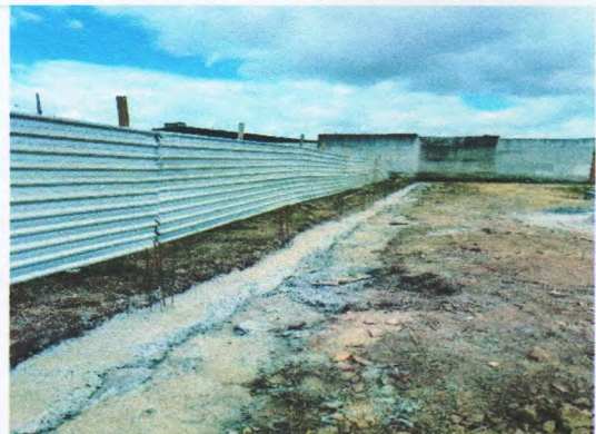
ALVENARIA DE PEDRA CALCARÉA (Coordenadas, comentários, etc.)
