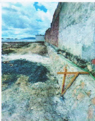
ALVENARIA DE PEDRA CALCARÉA (Coordenadas, comentários, etc.)
