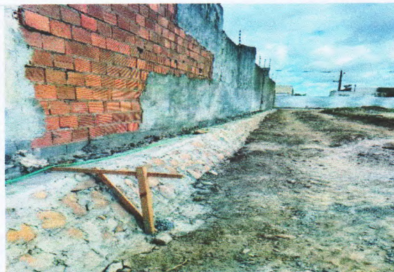
ALVENARIA DE PEDRA CALCARÉA (Coordenadas, comentários, etc.)
