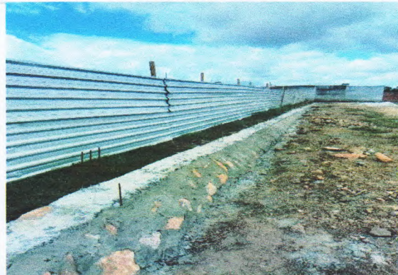
ALVENARIA DE PEDRA CALCARÉA (Coordenadas, comentários, etc.)
