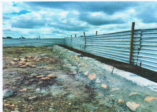
ALVENARIA DE PEDRA CALCARÉA (Coordenadas, comentários, etc.)
