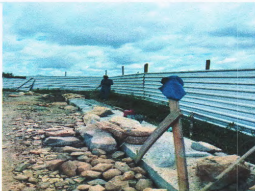
ALVENARIA DE PEDRA CALCARÉA (Coordenadas, comentários, etc.)
