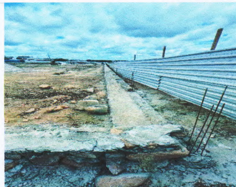
ALVENARIA DE PEDRA CALCARÉA (Coordenadas, comentários, etc.)
