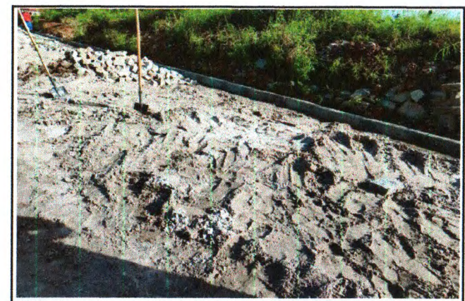
PAVIMENTAÇÃO DO TRECHO 02
