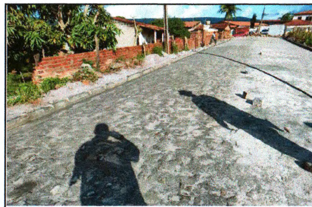
PAVIMENTAÇÃO DO TRECHO 02
