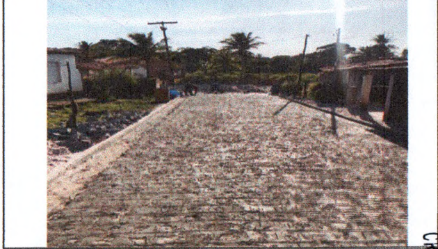
PAVIMENTAÇÃO EM PARALELEPÍPEDO
