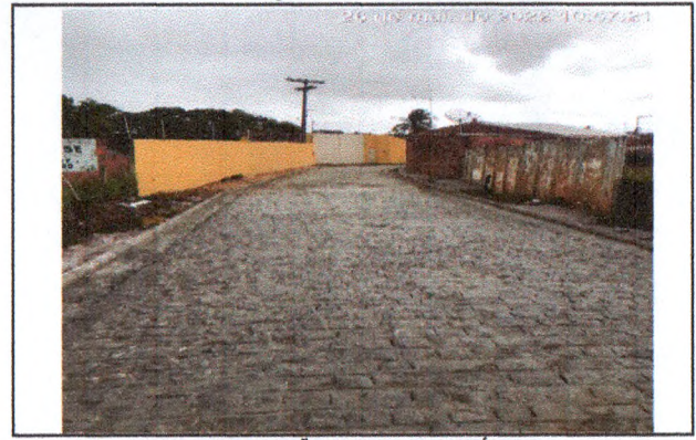
PAVIMENTAÇÃO EM PARALELEPÍPEDO
