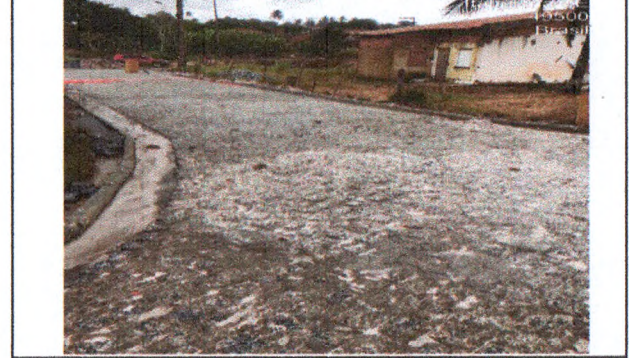
PAVIMENTAÇÃO EM PARALELEPÍPEDO
