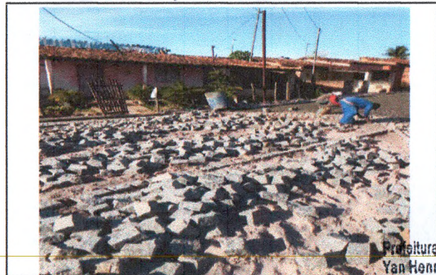
PAVIMENTAÇÃO EM PARALELEPÍEDO
