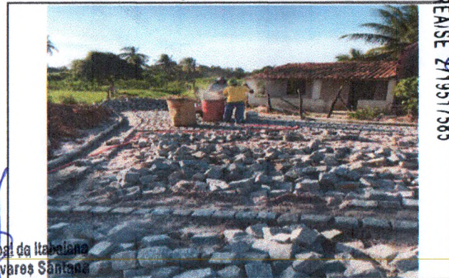
PAVIMENTAÇÃO EM PARALELEPÍEDO
