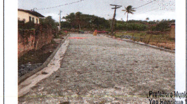
PAVIMENTAÇÃO EM PARALELEPÍPEDO
