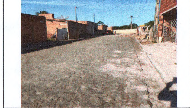
PAVIMENTAÇÃO EM PARALELEPÍPEDO
