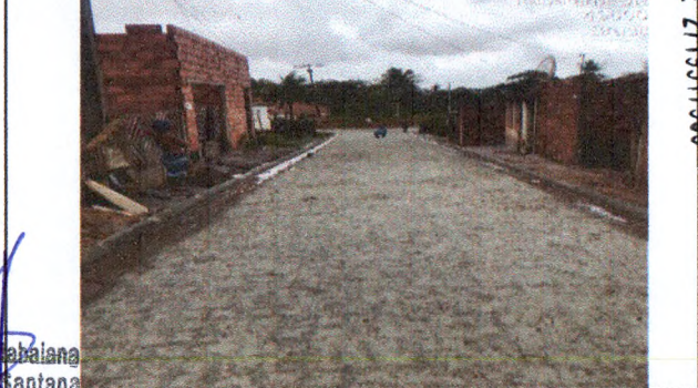
PAVIMENTAÇÃO EM PARALELEPÍPEDO
