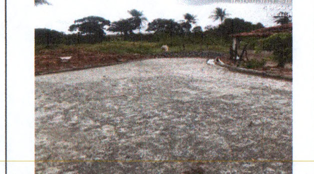
PAVIMENTAÇÃO EM PARALELEPÍPEDO
