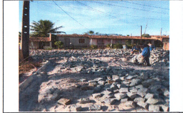
PAVIMENTAÇÃO EM PARALELEPÍEDO
