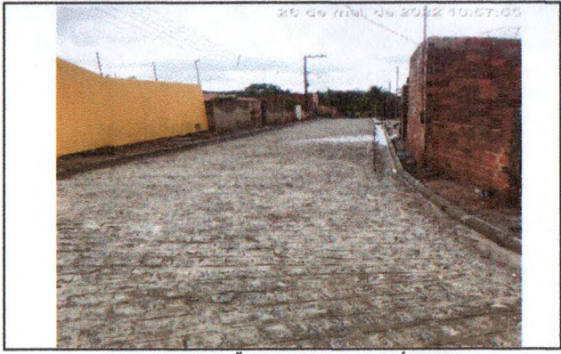
PAVIMENTAÇÃO EM PARALELEPÍPEDO
