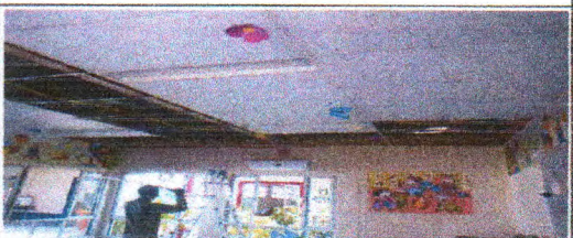
Locais onde será instalado Forro de gesso acartonado, cor branca, placa 1243 x 618mm
