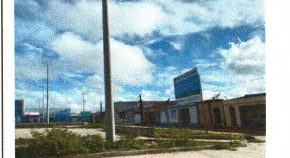
INSTALAÇÃO DOS POSTES, PLACA DE OBRA
