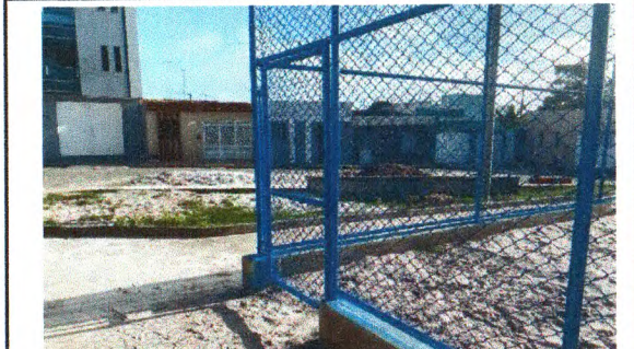
INSTALAÇÃO DOS PORTÕES, EXECUÇÃO DO ALAMBRADO, INSTALAÇÃO DOS POSTES
