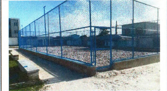
EXECUÇÃO DO ALAMBRADO, INSTALAÇÃO DOS PORTÕES, EXECUÇÃO DE CHAPISCO E REBOCO
