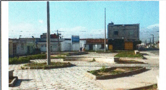
INSTALAÇÃO DOS POSTES, PLACA DE OBRA
